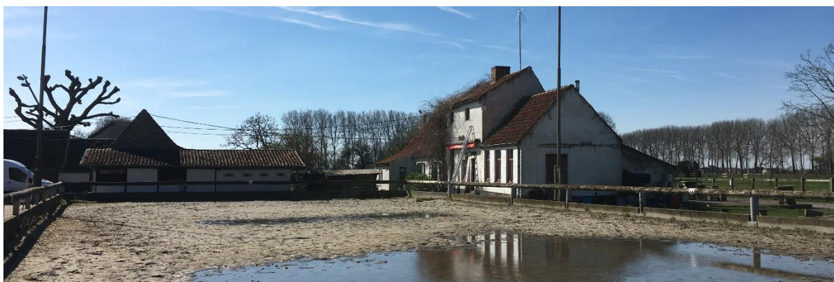
Figuur 22 : Zicht op het plangebied ter hoogte van boring 13 en 16, gezien vanuit het noordoosten.
