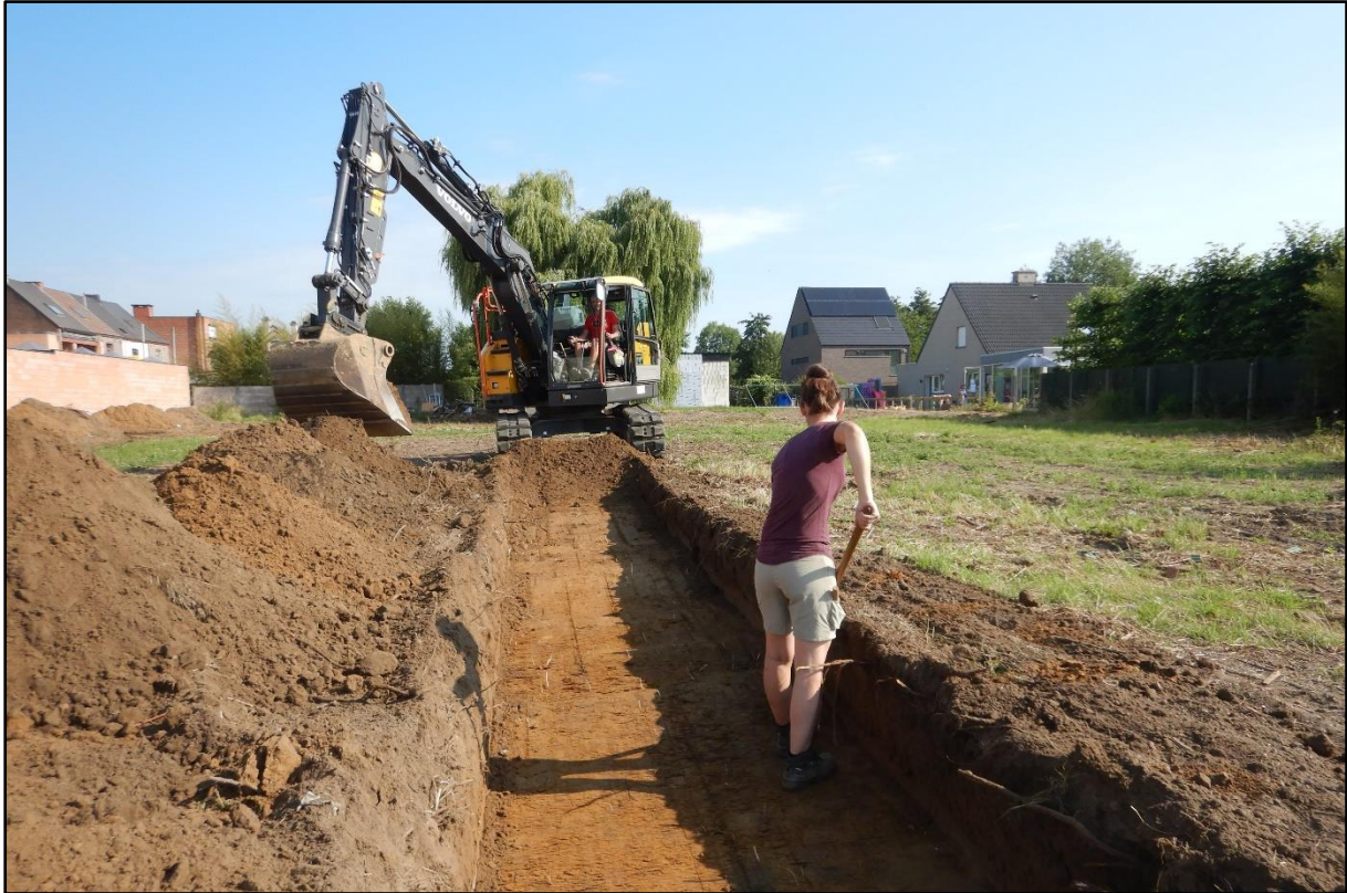
Figuur 6 Aanleg en opschaven van de proefsleuven.
