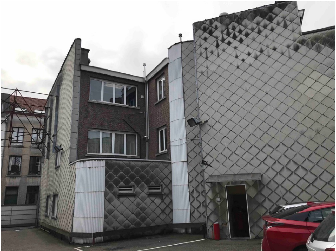
Fig. 4 Foto van de achtergevel van het kantoorgebouw aan de Vekestraat 27. © Het Transport
