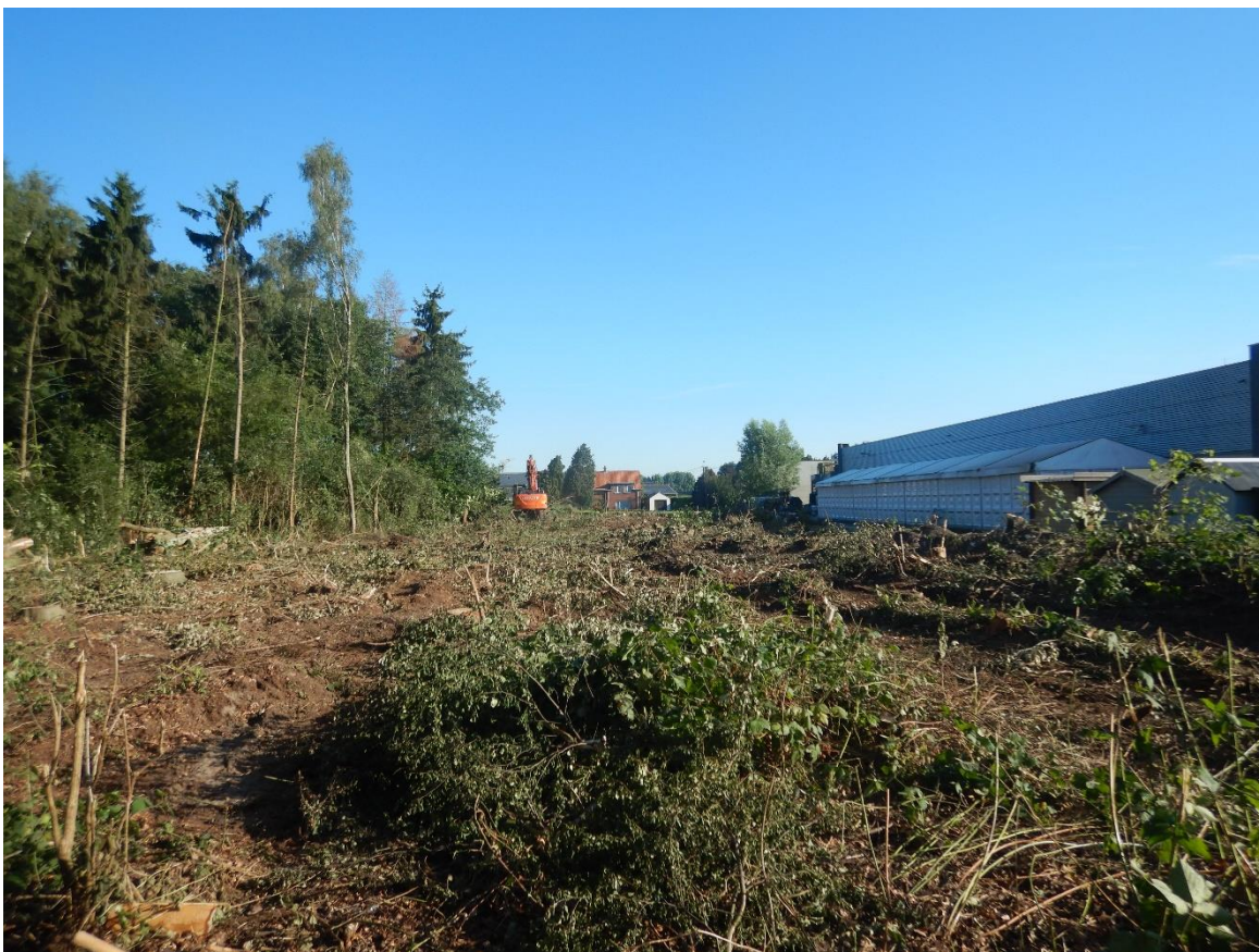
Figuur 20: Zicht op het terrein vanuit zuidelijke hoek, voor de aanvang van het onderzoek. Het aanwezige bos werd gerooid, de stammen bleven ongefreesd.
