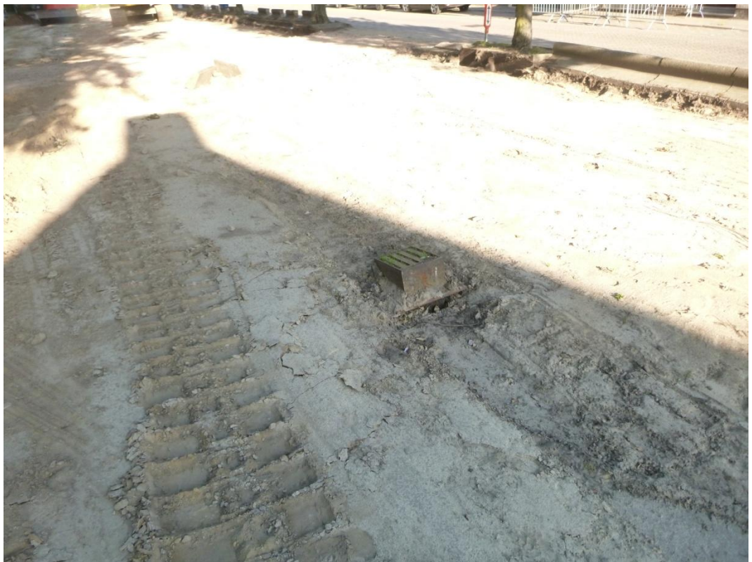
Afb. 29. Zicht op het rioolputje in het verlengde van de sleuf.
