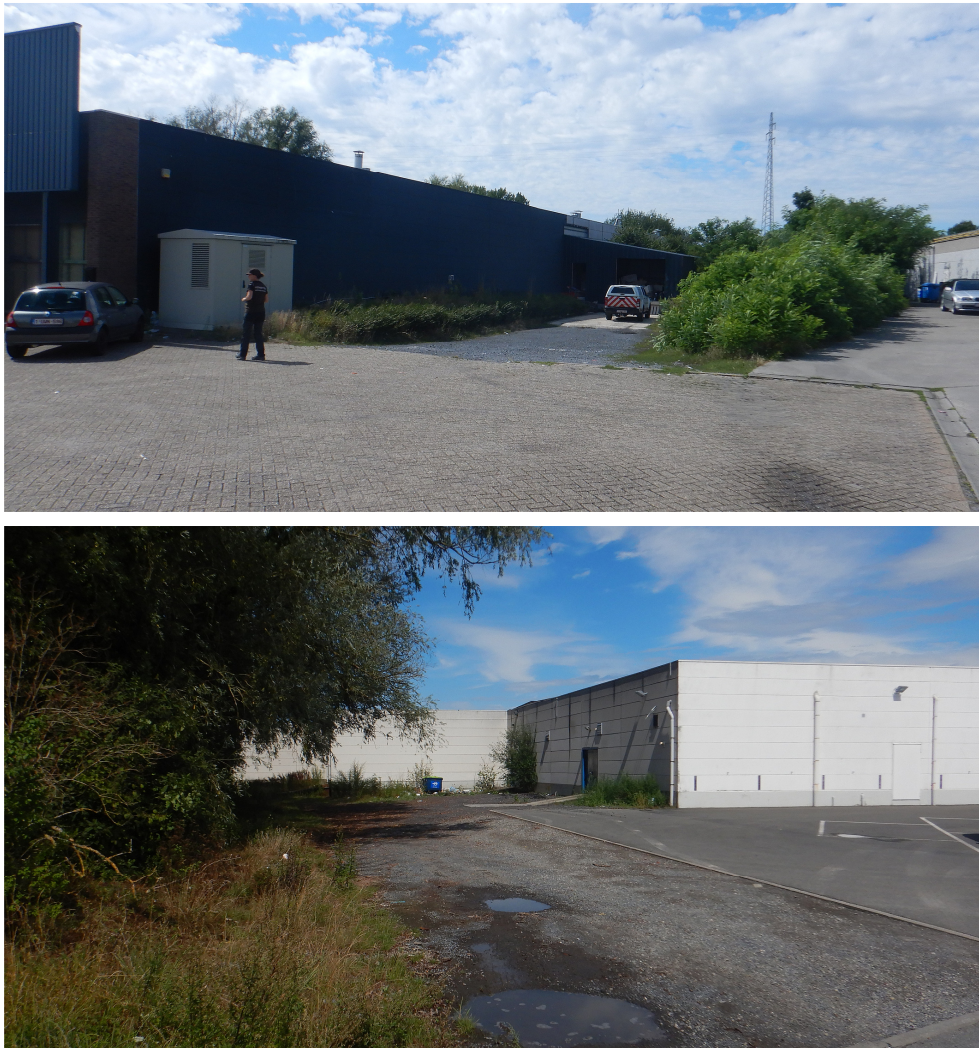
Figuur 14. Noordelijke en zuidelijke zijde van het bestaande en voor 2/3 leegstaande complex.
