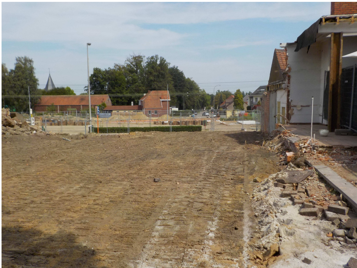
Afbeelding 12: Impressie van het plangebied na het beëindigen van de sloopwerkzaamheden.
