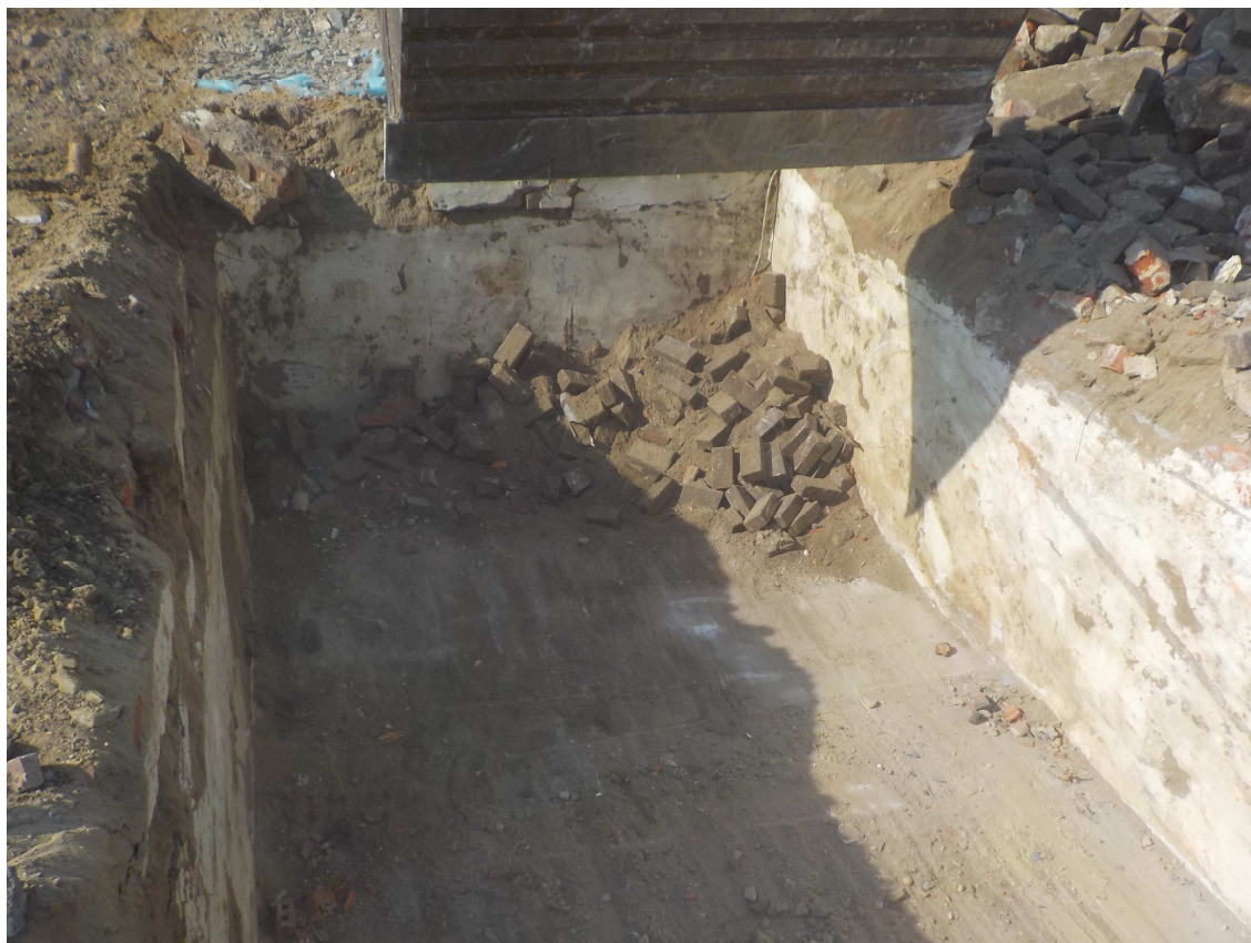
Afbeelding 11: Impressie van de aanwezige kelder.
