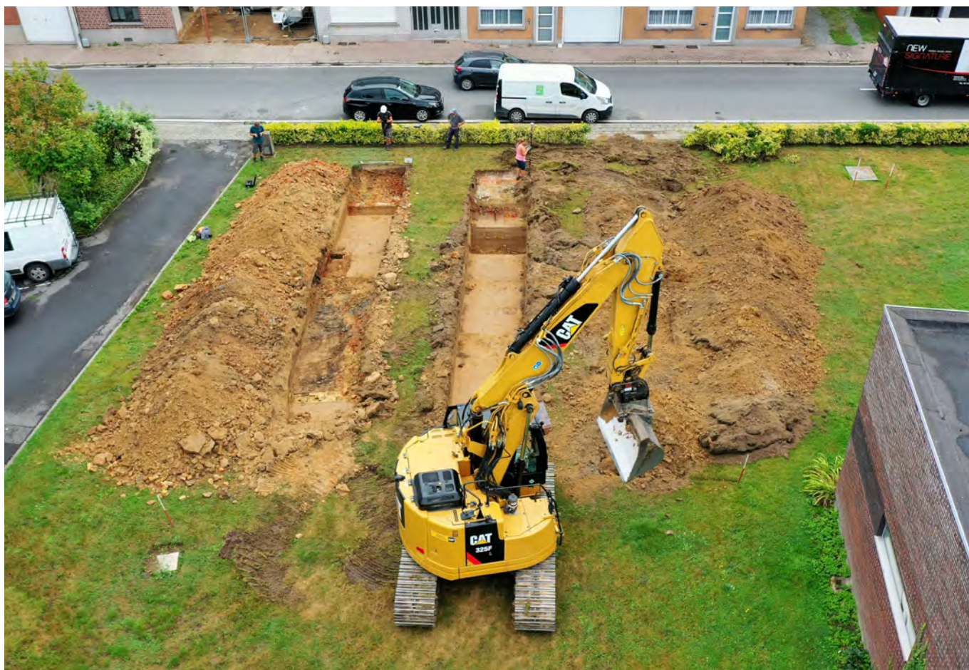
Figuur 16: Overzicht van de aangelegde sleuven met zicht op één van de toegangswegen en de aanwezige leidingputten
