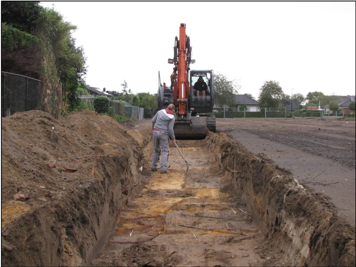
Figuur 5 Aanleg en opschaven van de proefsleuven en aanduiden van de sporen en verstoringen.
