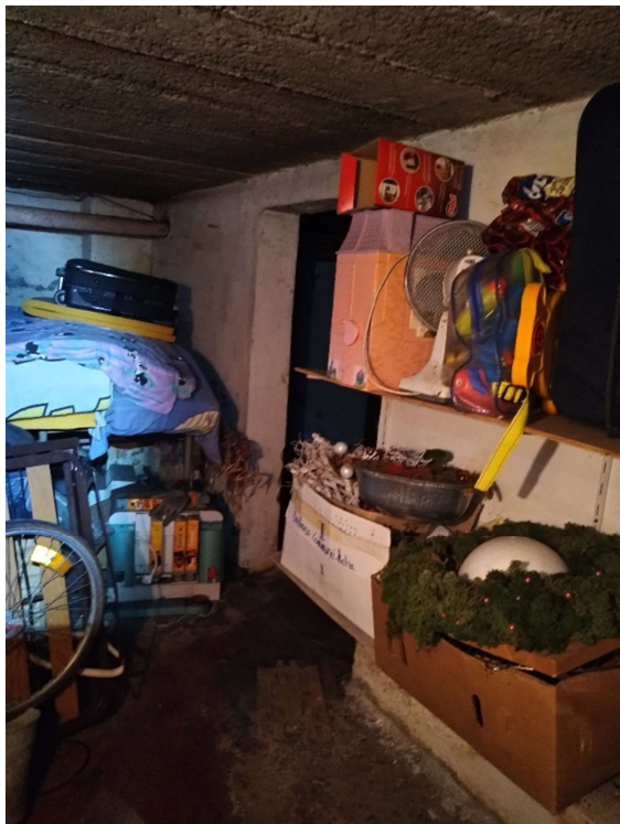
Figuur 4. De kelder onder woning nr. 80.
