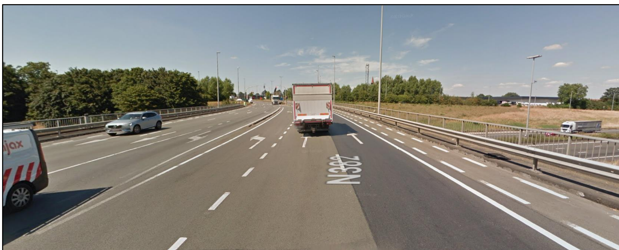
Figuur 4: De brug over de autosnelweg E17 binnen het projectgebied Google Maps 2020)
