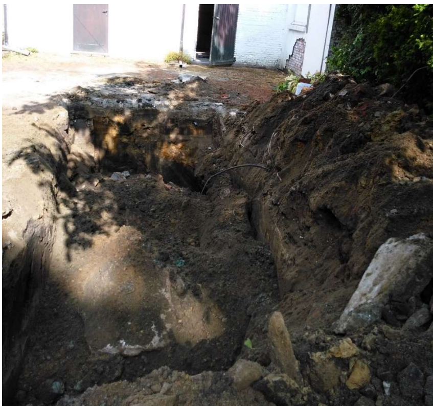
Figuur 4. De sanering van de mazouttank in 2018. ©BOUWHEER
