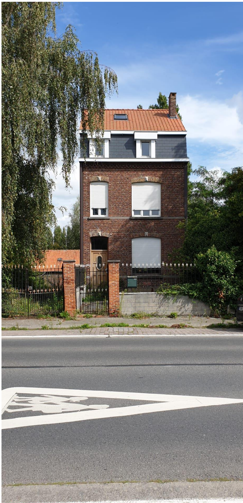
Figuur 1: Vooraanzicht van de woning ter hoogte van het projectgebied
