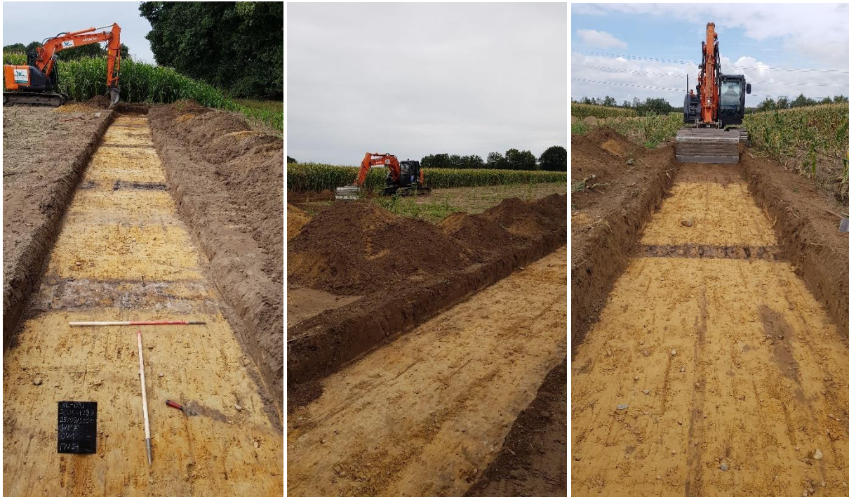
Figuur 5. Zicht op aanleg van de sleuven.
