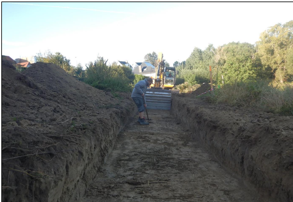
Figuur 5 Aanleg en opschaven van de proefsleuven.
