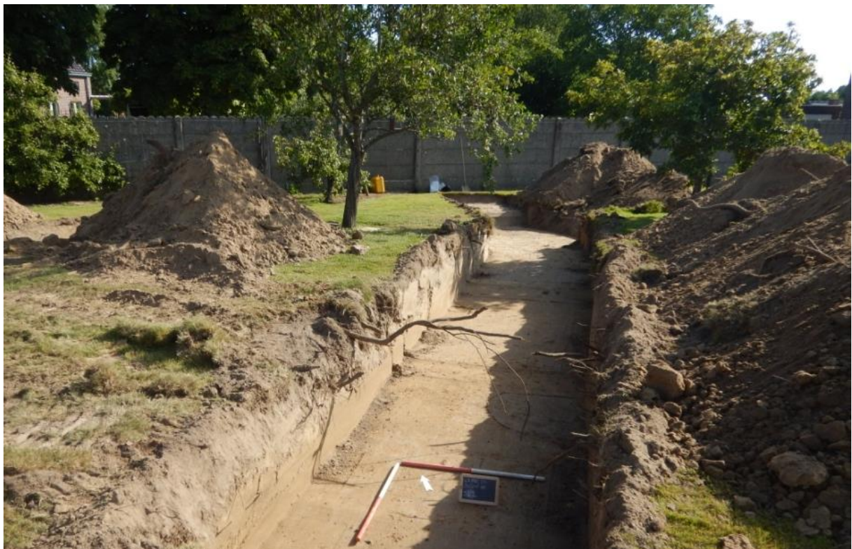
Figuur 5: Overzicht op sleuf 2 aangelegd tussen de bomen. Deze bomen worden mee opgenomen in de verkaveling.
