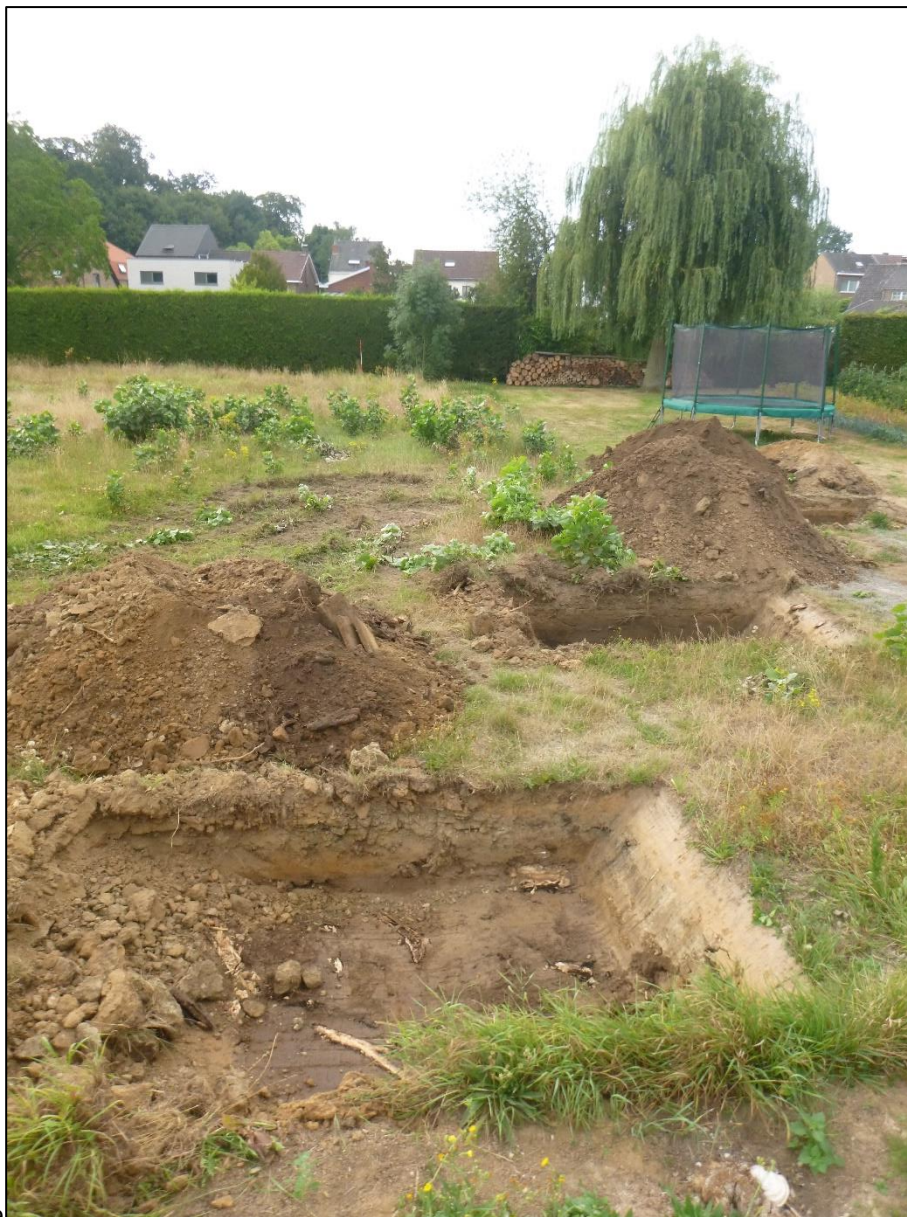
Figuur 15: Foto's methodiek: Het afgraven van het bovenliggende ophogingspakket
