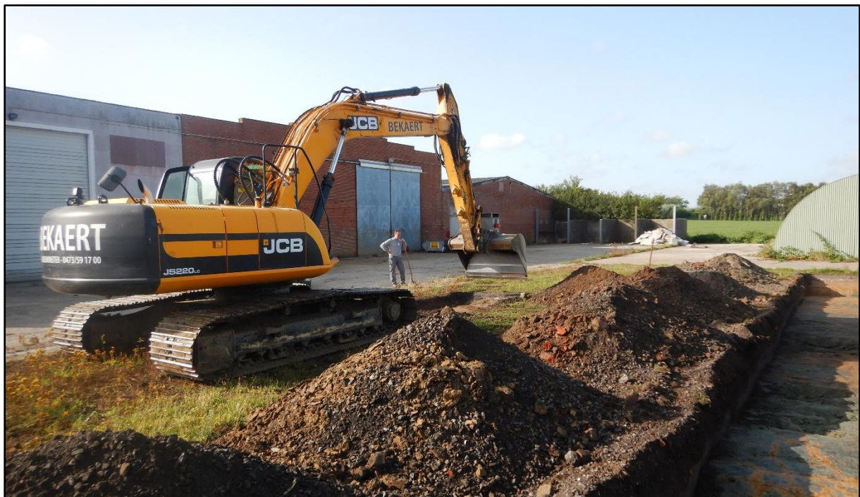
Figuur 6 Sfeerbeeld tijdens de aanleg van de sleuven.
