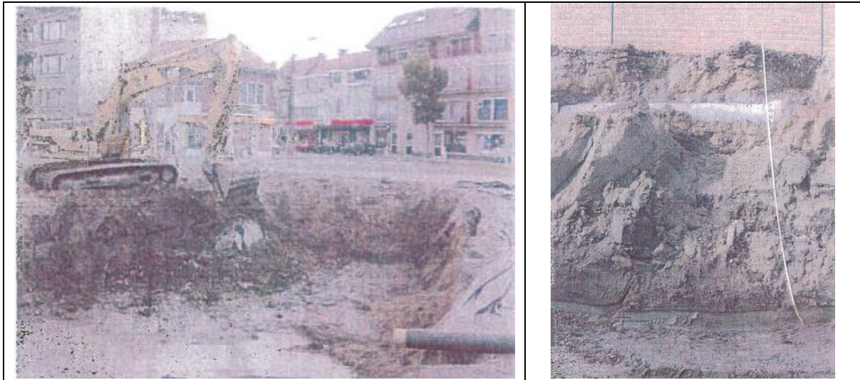
Figuur 10: zicht 6 op de afgraving langsheen de collector (links) en op de diepte van de ontgraving (rechts)
