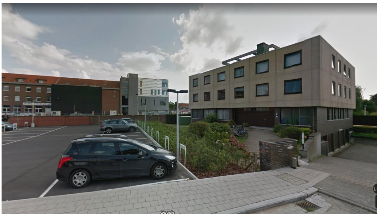
Figuur 17: Rode-Kruisstraat nr. 20 met verdiept niveau (bron: google.be)
