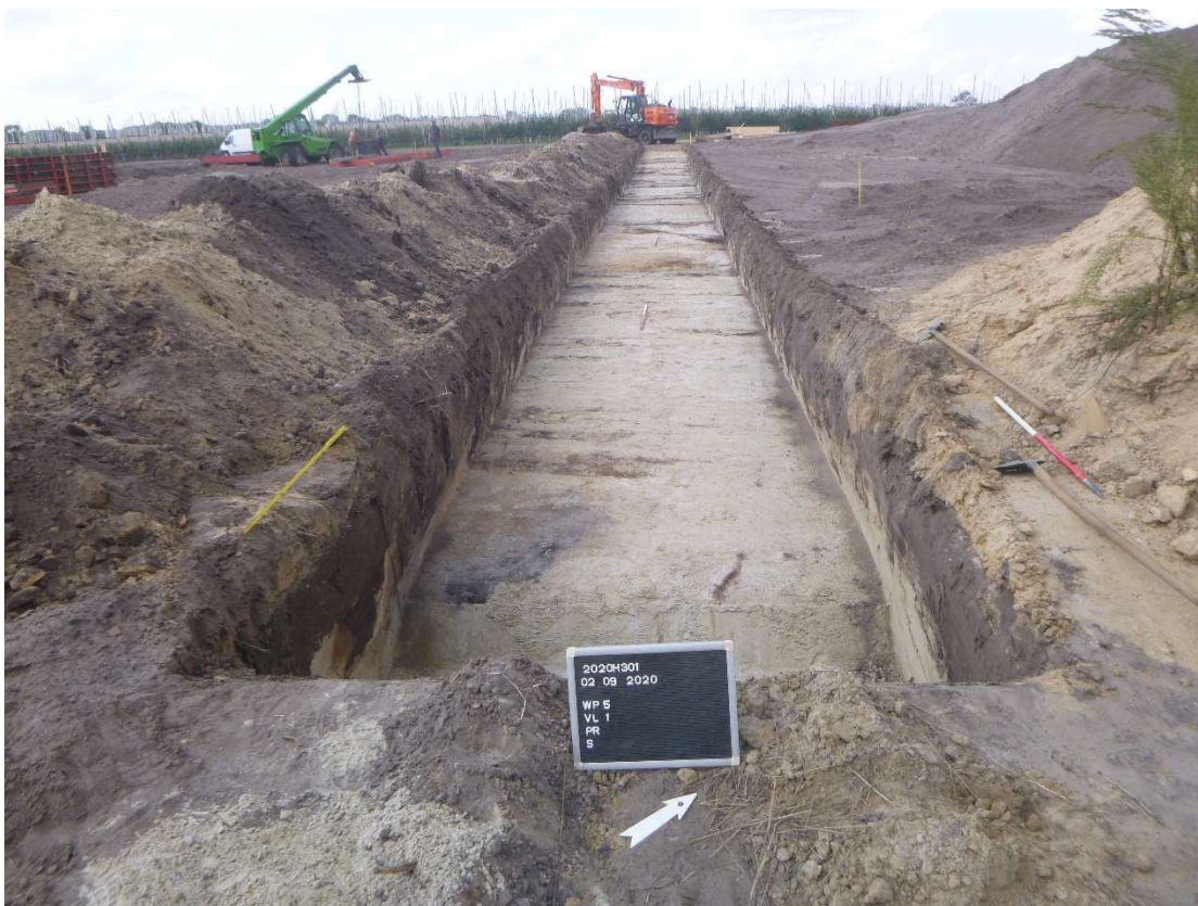
Figuur 29. Werkput 5. ©LARES
