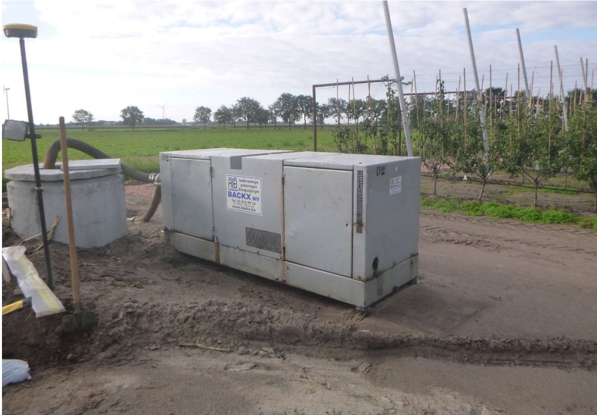
Figuur 12. Zicht op de bemaling op het zuidoostelijk deel van het terrein. ©LARES
