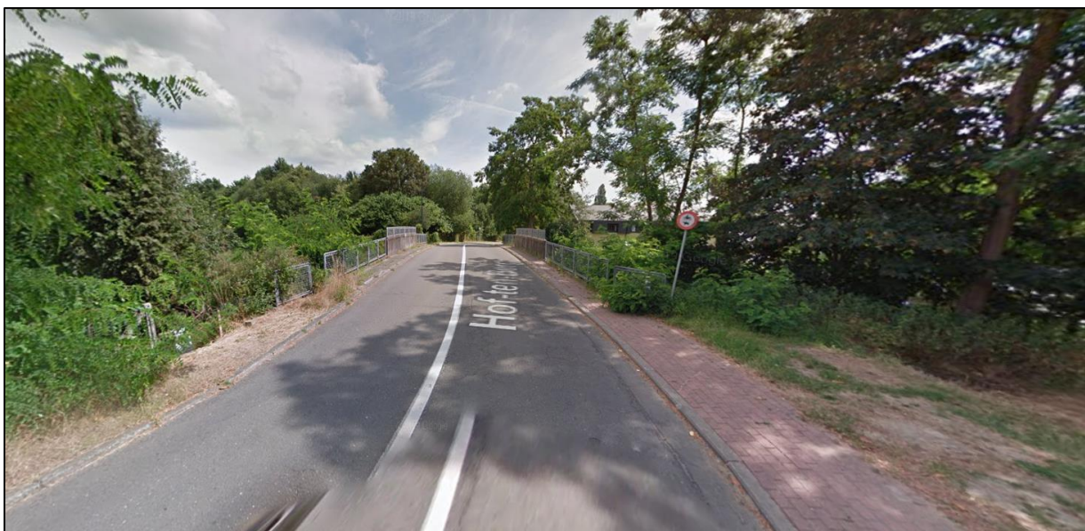
Figuur 7: De huidige brug over spoorlijn 124 (Google Maps 2019)
