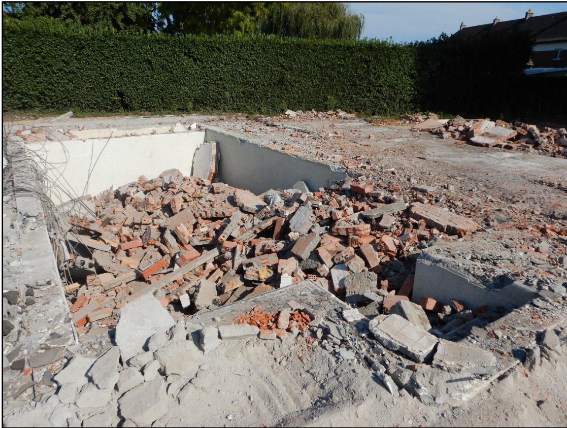
Figuur 2 Zicht op de kelder in het noordelijk deel van de villa.
