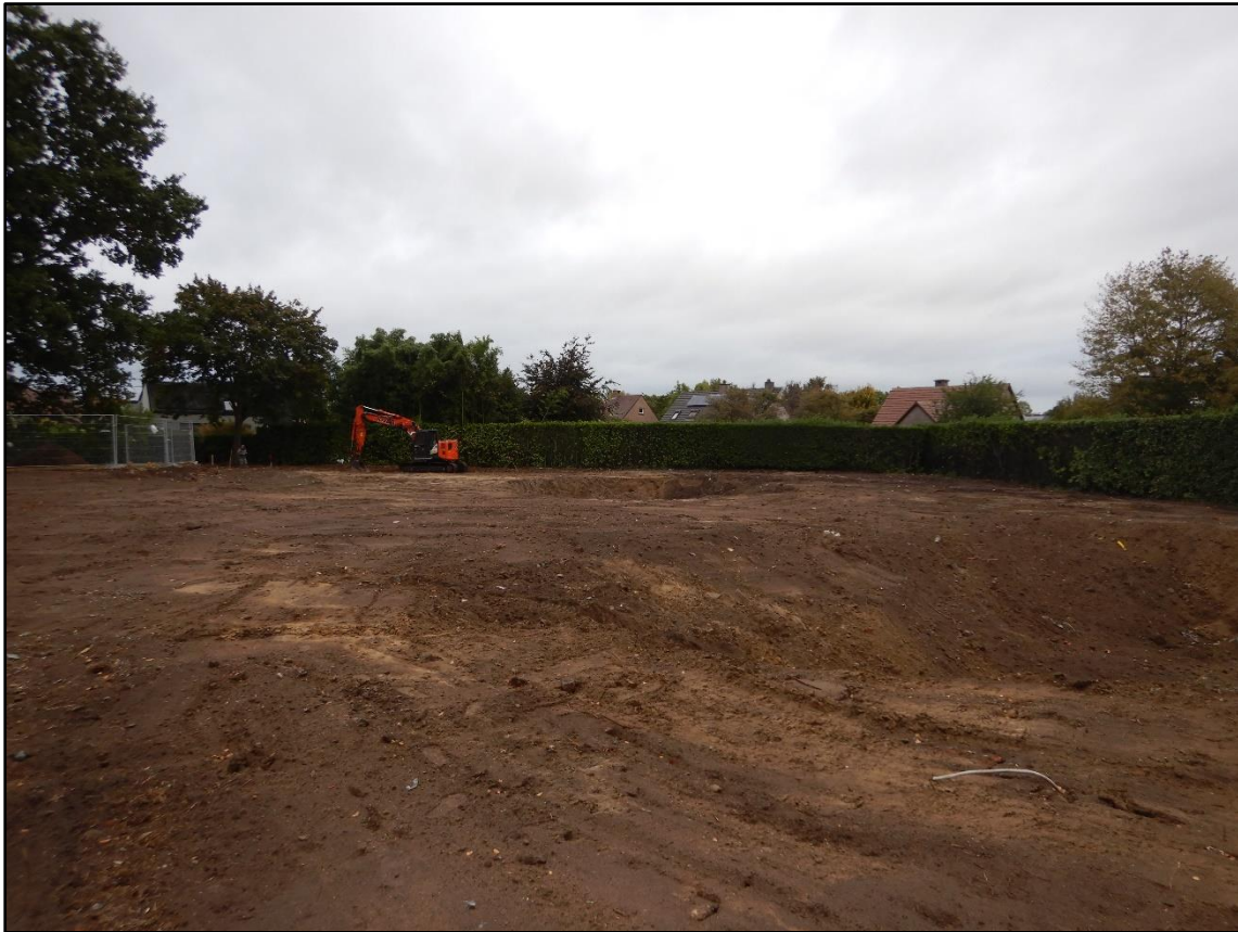
Figuur 9 Zicht op het plangebied, vanuit zuidelijke richting.
