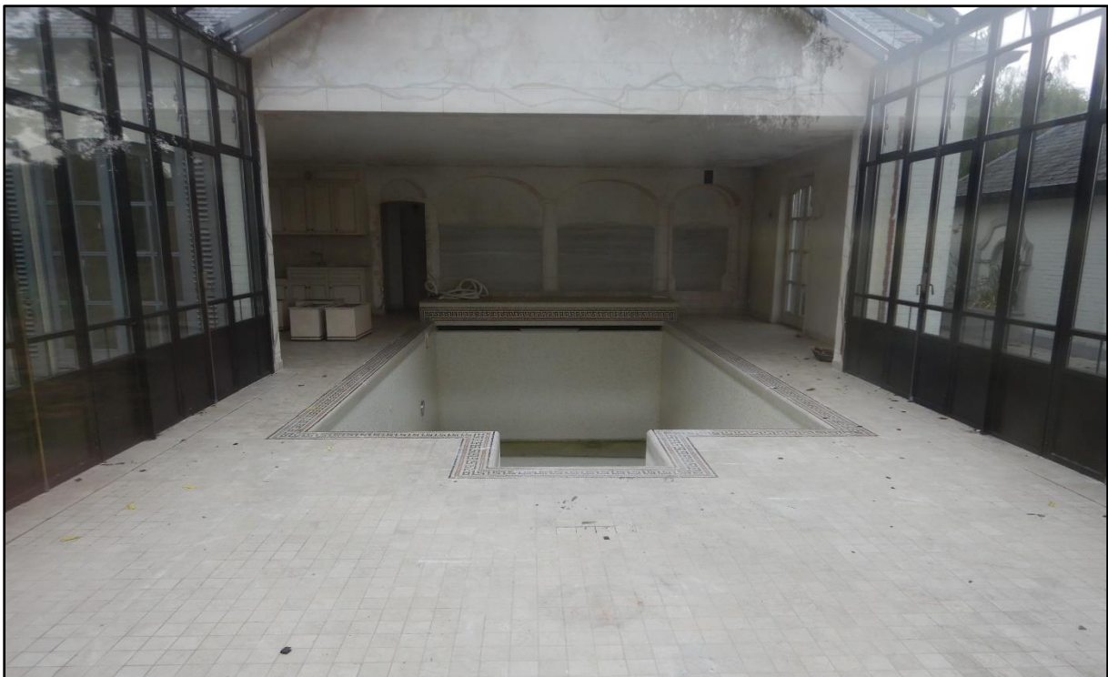
Figuur 1 Zicht op het binnenzwembad in het zuidelijk deel van de villa, voor de afbraak.
