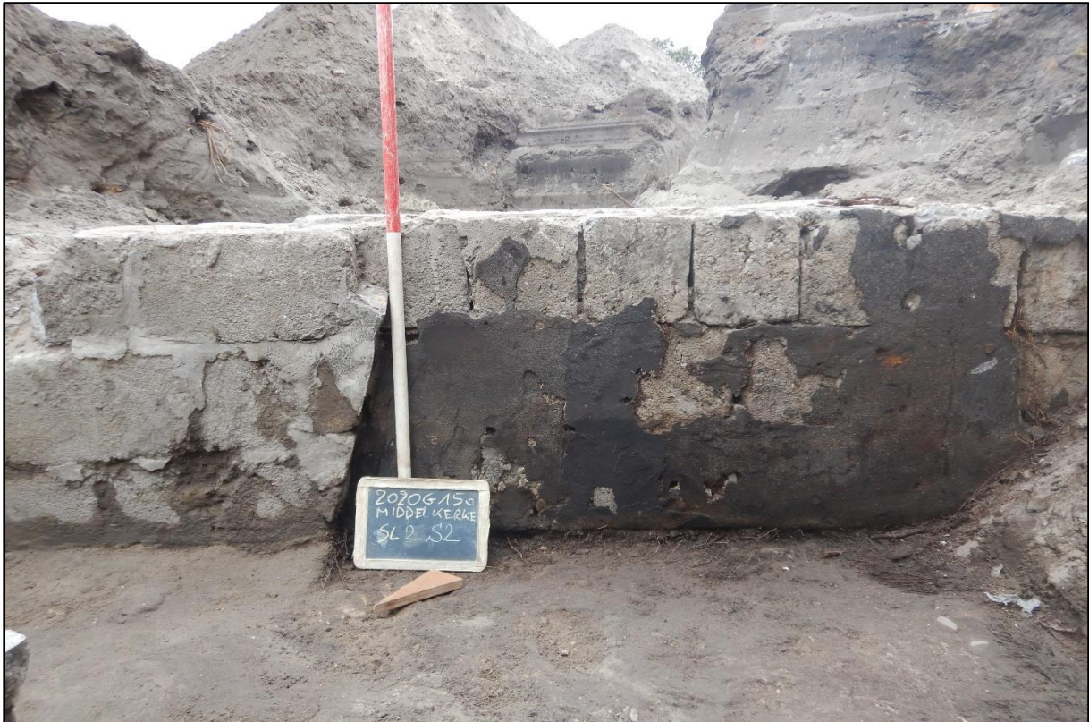
Figuur 24 Interne ruimte van de eerste bunker waarbij de interne muren afgewerkt werden met pek. Merk ook duidelijk de opbouw van de muren op met betonblokjes en de schuin afgewerkte toegang.
