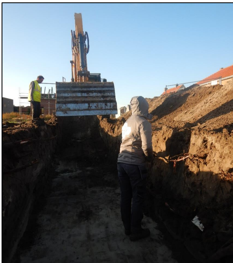
Figuur 5 Aanleg en opschaven van de proefsleuven onder begeleiding van de ontmijner.
