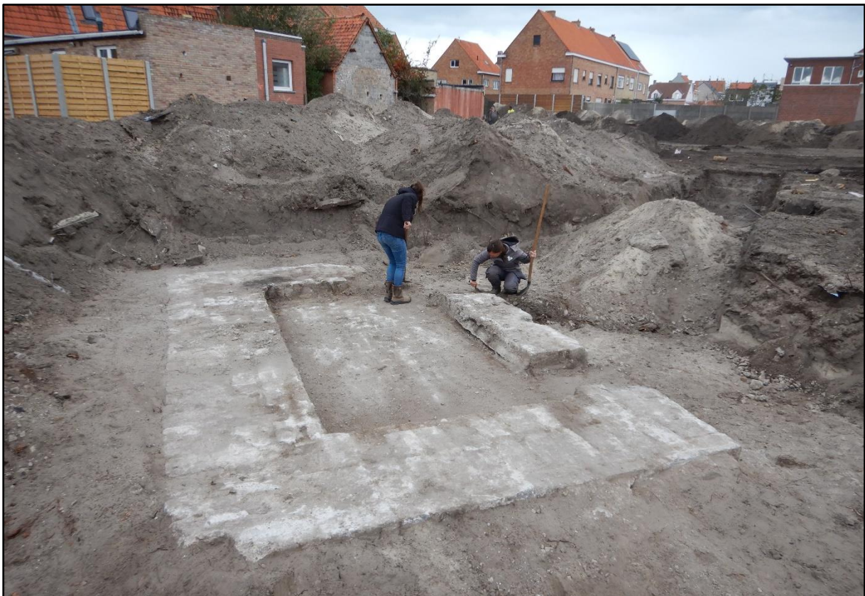
Figuur 8 Vrijleggen van de centrale bunker S3.
