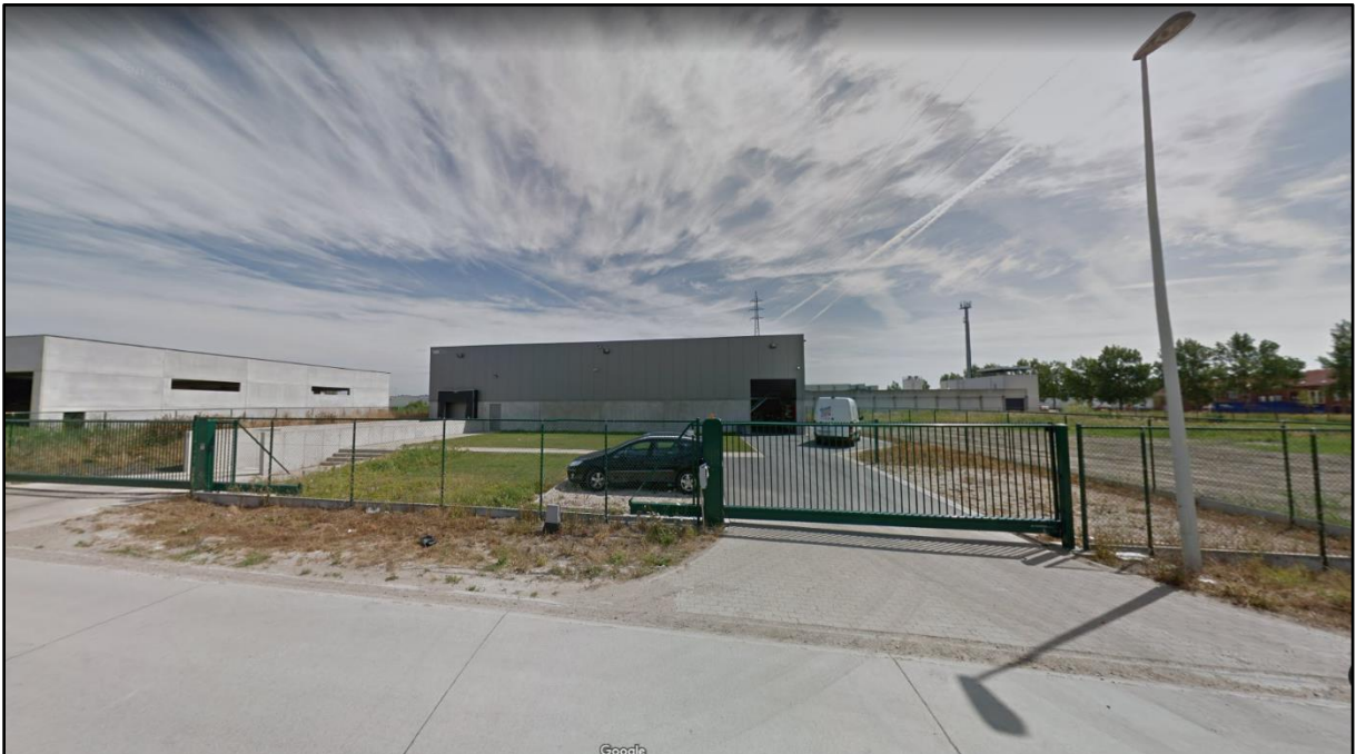
Figuur 4 Zicht op het fabrieksgebouw in de westelijke uitstulping vanaf de IJslaan (bron: https://www.google.com/maps ).
