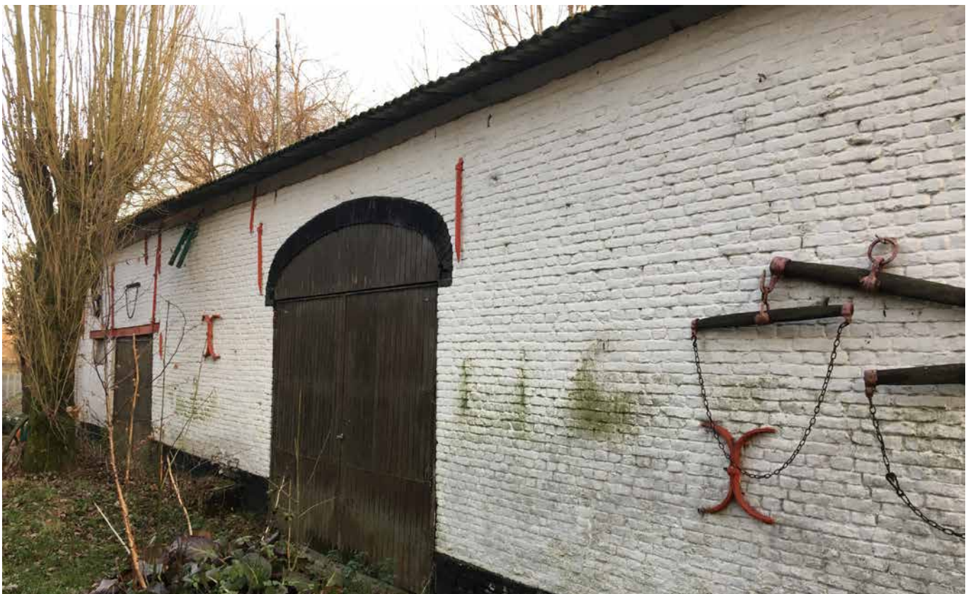
Figuur 9: Foto 3 van de terreininspectie, met zicht op de grote schuur
