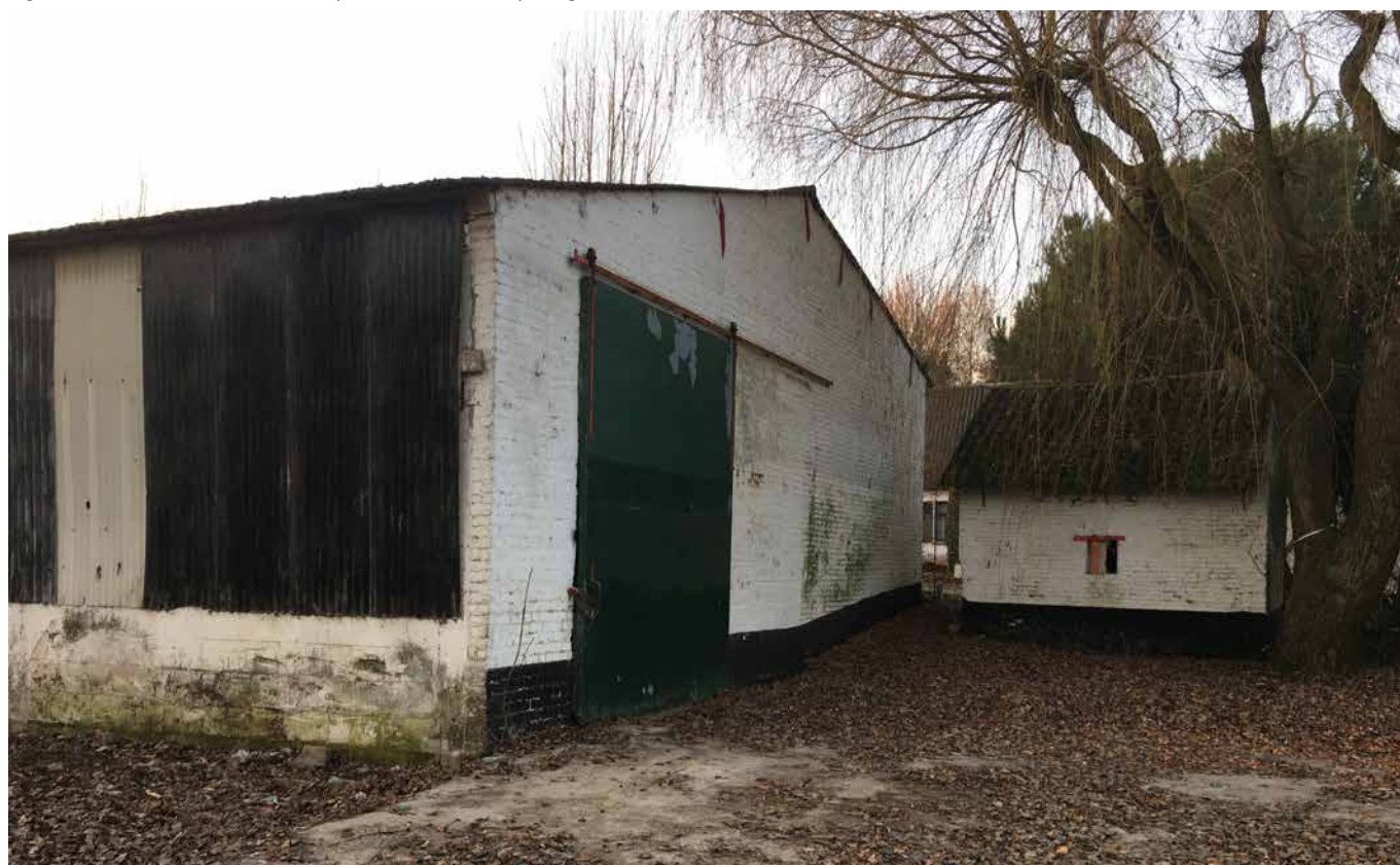
Figuur 7: Foto 1 van de terreininspectie, met zicht op de grote schuur
