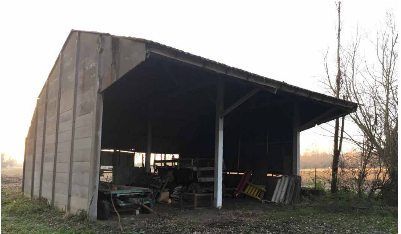
Figuur 8: Foto 2 van de terreininspectie, met zicht op de open schuur
