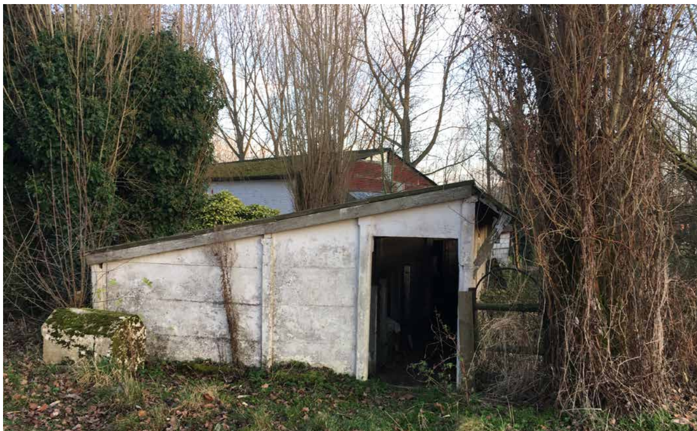
Figuur 11: Foto 5 van de terreininspectie, met zicht op de kleine stalling
