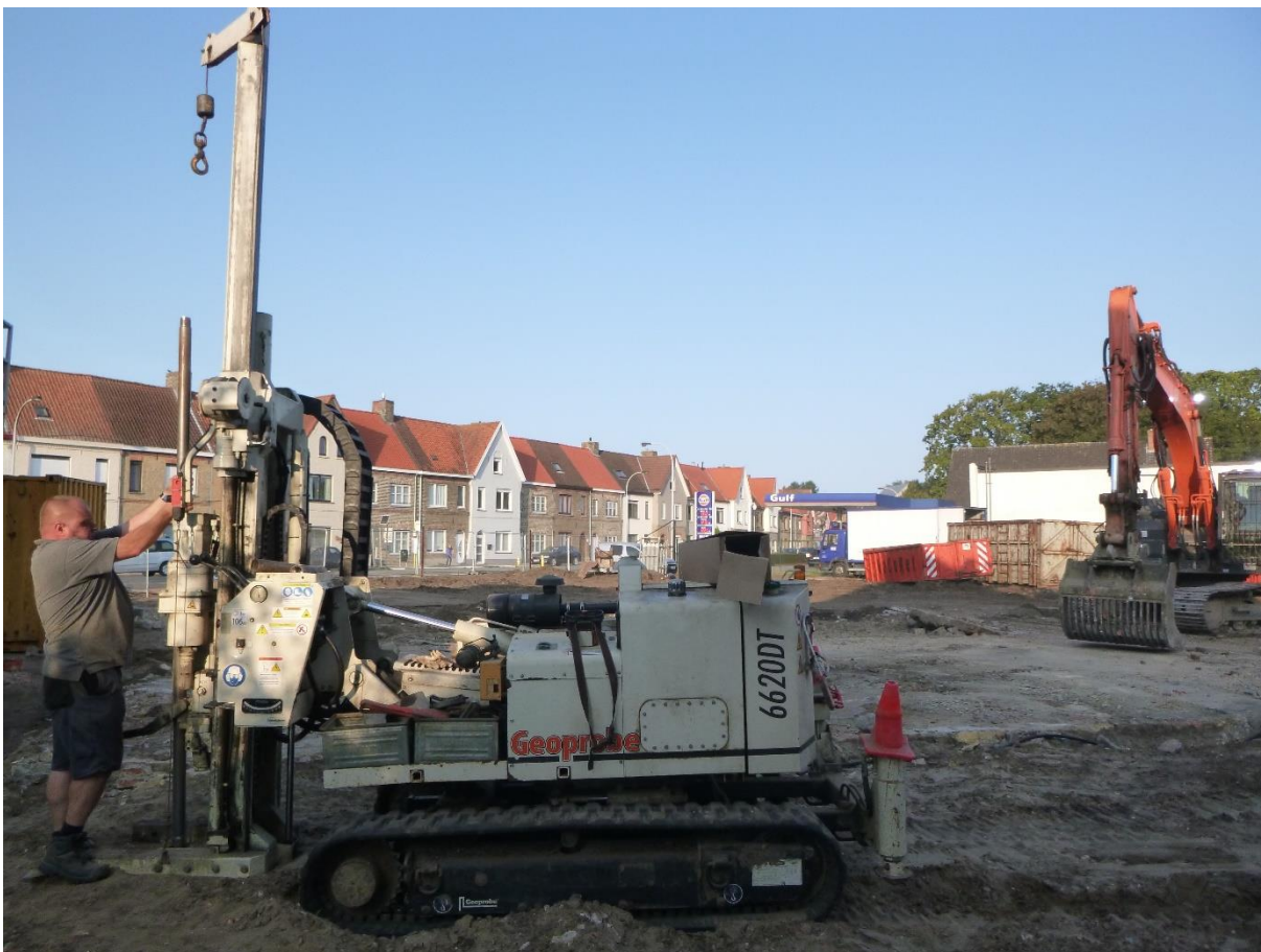
Figuur 3: Zijaanzicht van de gebruikte Geoprobe boormachine tijdens dit booronderzoek.
