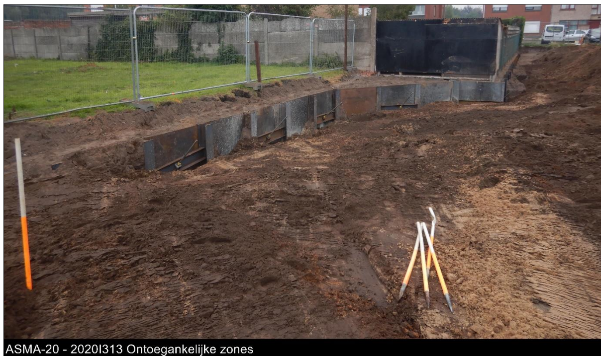
Figuur 10: Damwanden
