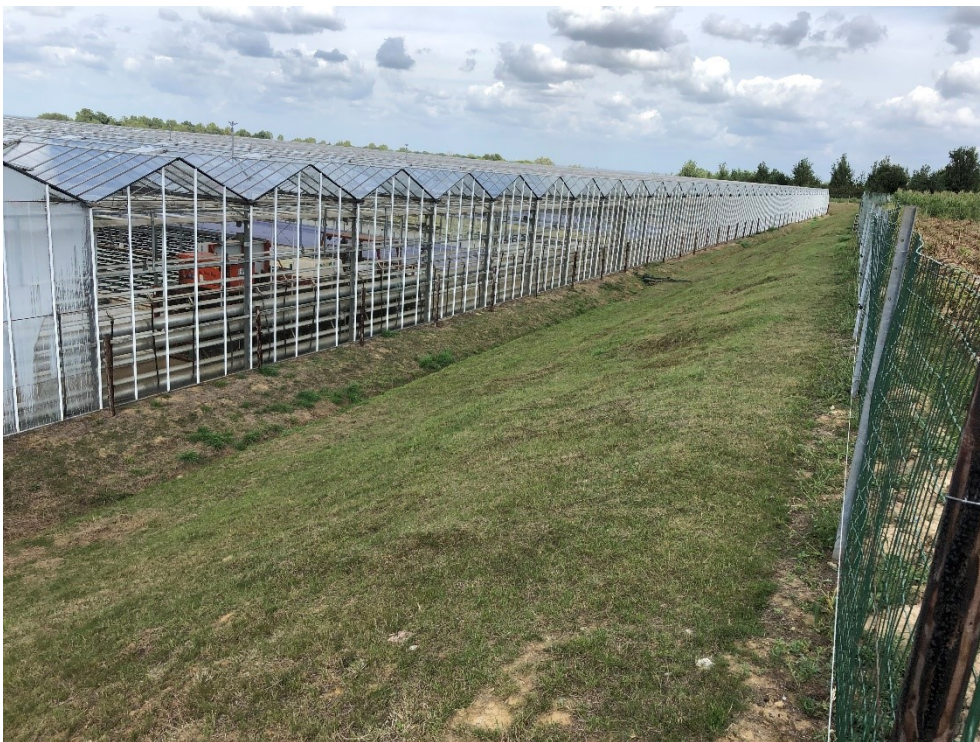
Figuur 9: Foto van de bestaande toestand (6), met zicht op de bestaande serres, gezien vanaf het noordwesten
