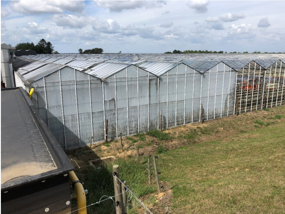
Figuur 8: Foto van de bestaande toestand (5), met zicht op de bestaande serres, gezien vanaf het noordwesten
