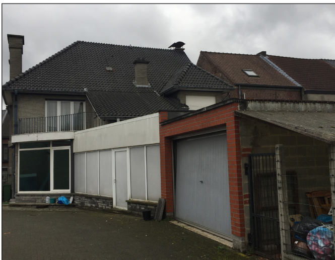
Figuur 9: Huidig te slopen bebouwing
