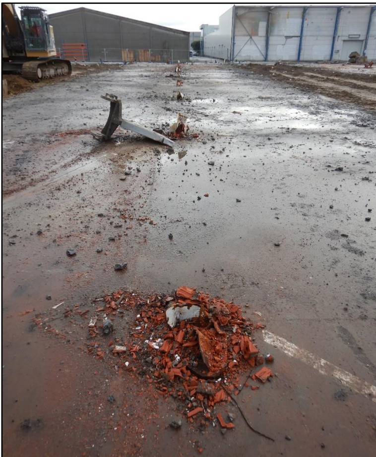
Figuur 3 Zicht op de metalen en gebetonneerde funderingen tussen twee proefsleuven.
