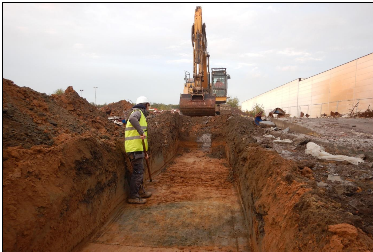
Figuur 7 Sferbeeld tijdens de aanleg van sleuf 3.
