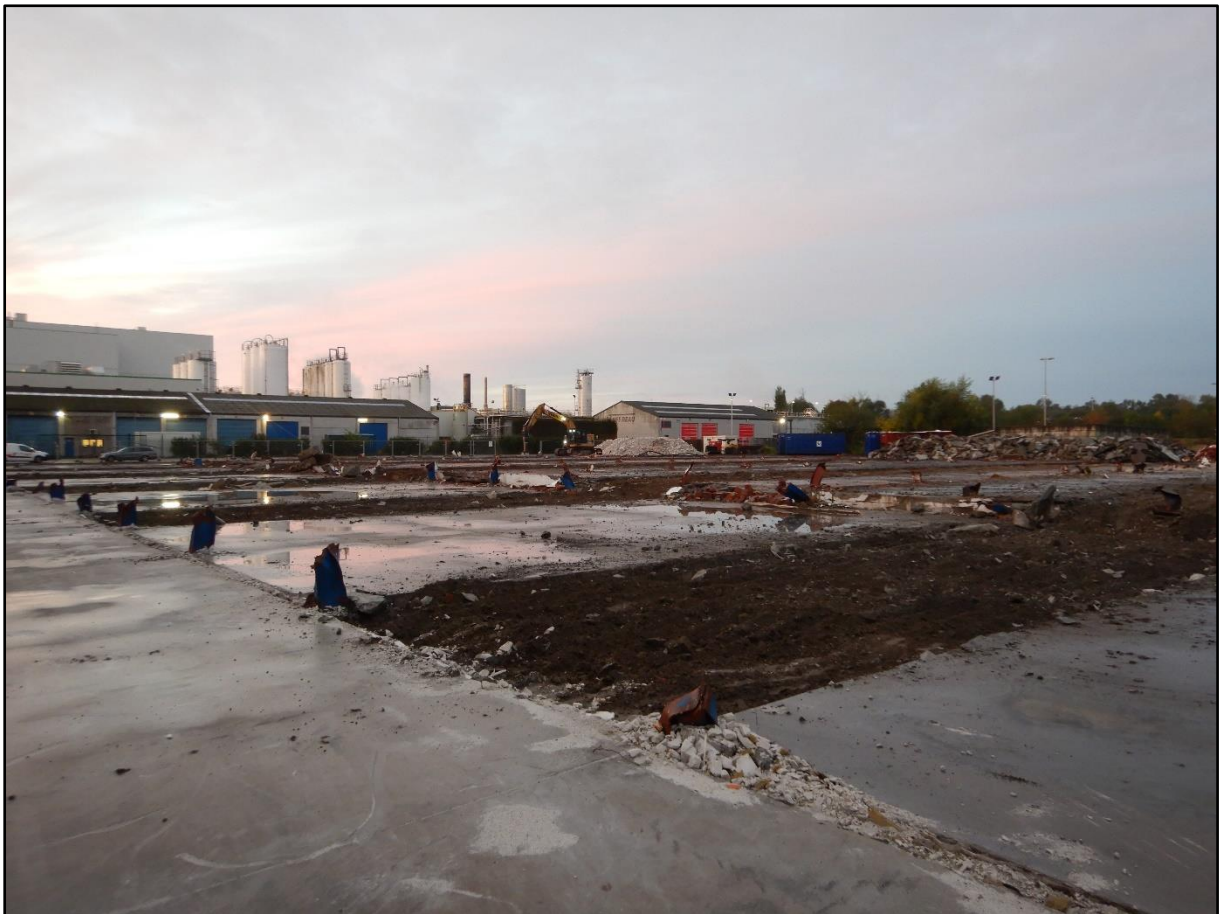
Figuur 1 Zicht op het plangebied (fase 1) na de bovengrondse sloop vanuit het noordoosten.
