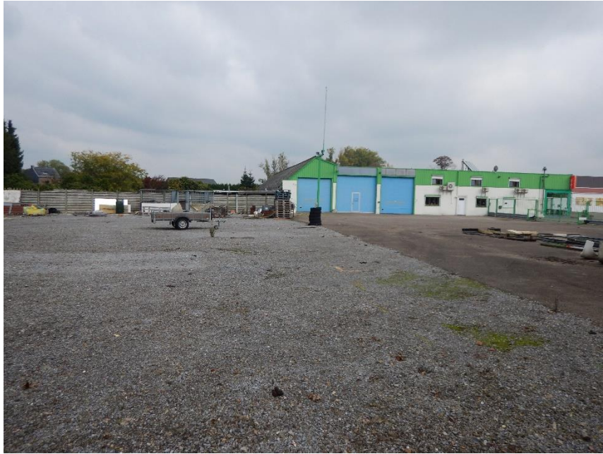
Fig. 23: De buitenopslag aan de noordzijde van het terrein met grind- en betonverharding.
