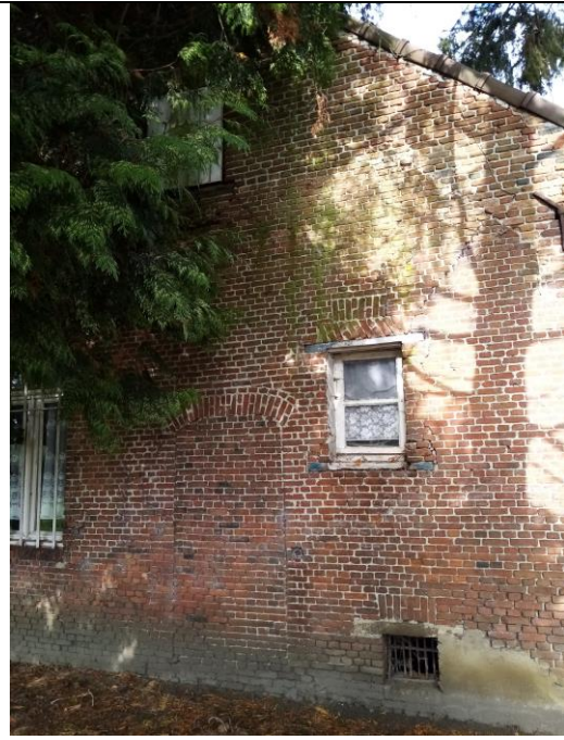
Foto 8: Straatzijde van de woning, met onderaan het kelderraam.
