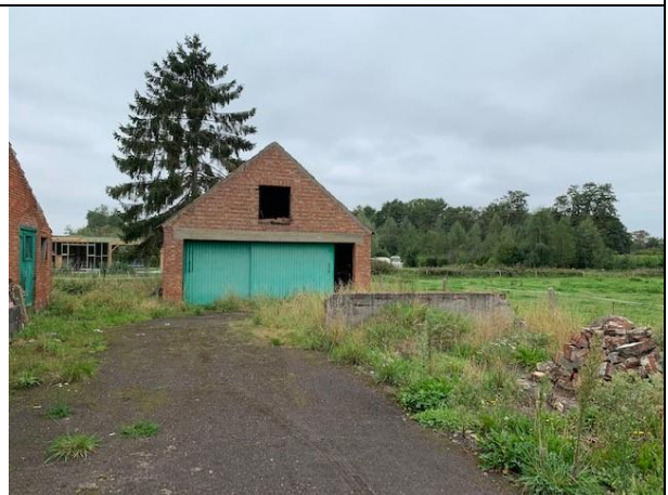
Foto 4: Één van de bijgebouwen. Rondom de woning werd het terrein verhard. Er ligt afbraak op het terrein.
