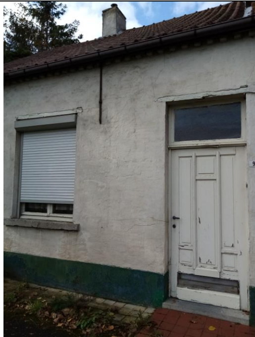
Foto 7: De woning met houten draagbalken boven de deur en vensters.
