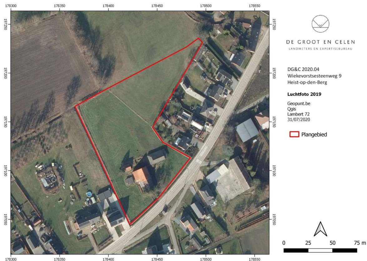
Figuur 17: Luchtfoto uit 2019.
