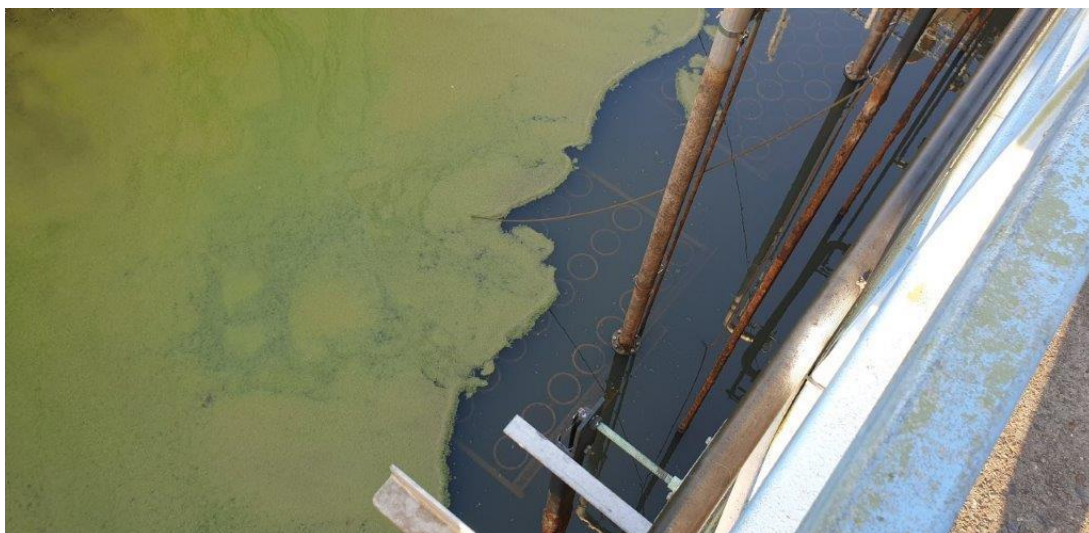
Figuur 17: Foto van waterzuiveringsinstallatie: detail 5 20
