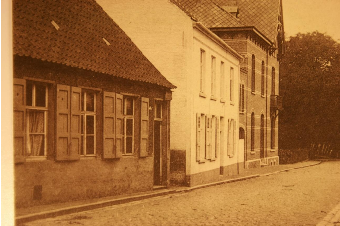
Figuur 35: De kasteelstraat (voorheen Rijkenhoekstraat) met tussen de herberg en het witte gebouw de Achterweidestraat als wegel (ongedateerd, voor 1951) (foto Jos Winckelmans)
