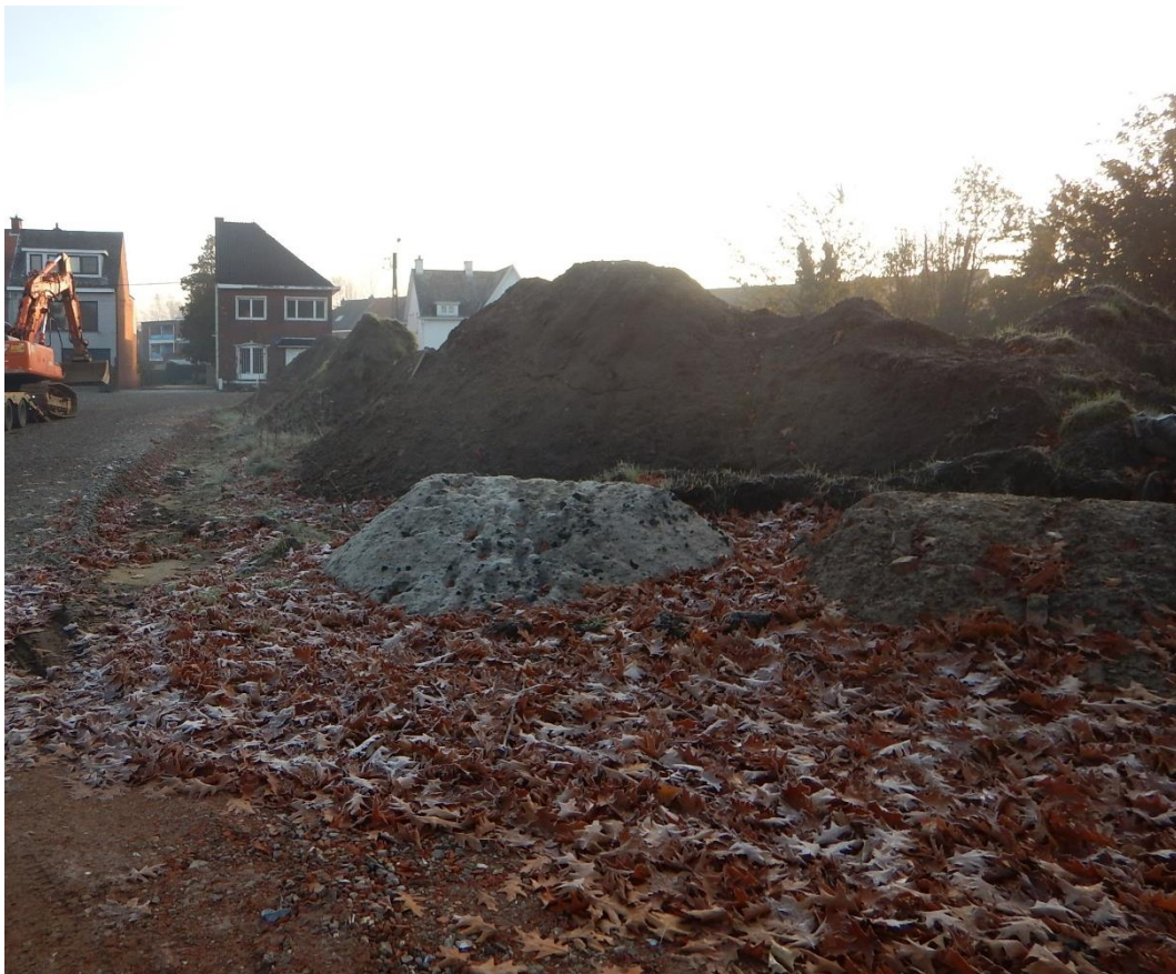
Figuur 13: Bergen grond en werfweg in niet onderzoekbare zone
