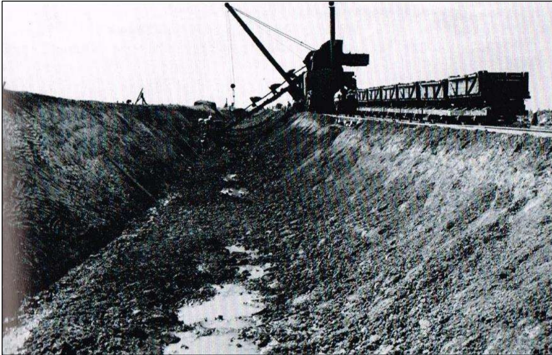
Figuur 22: aanleg van de anti-tank gracht bij het Stützpunkt Vlissingen (bron: Sakkers & Houterman 2000, 52-53)
