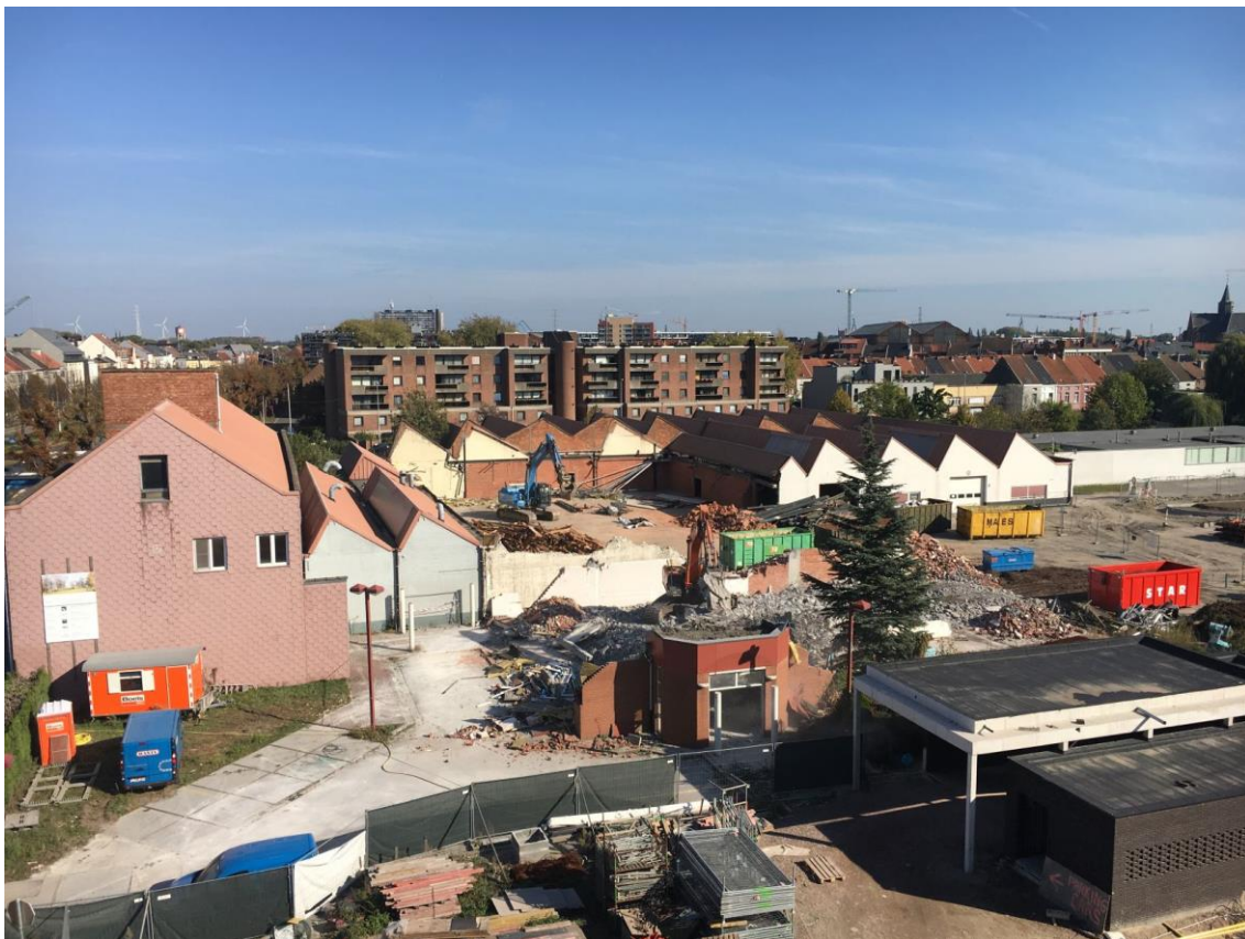
Figuur 4: Sloop van de gebouwen ter hoogte van het onderzoeksgebied
