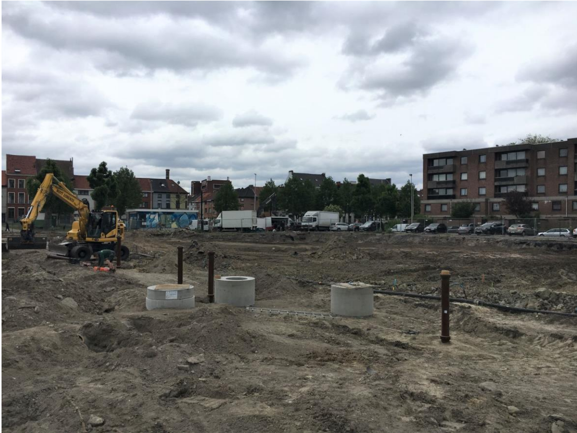
Figuur 6: Uitgravingen ter hoogte van het onderzoeksgebied
