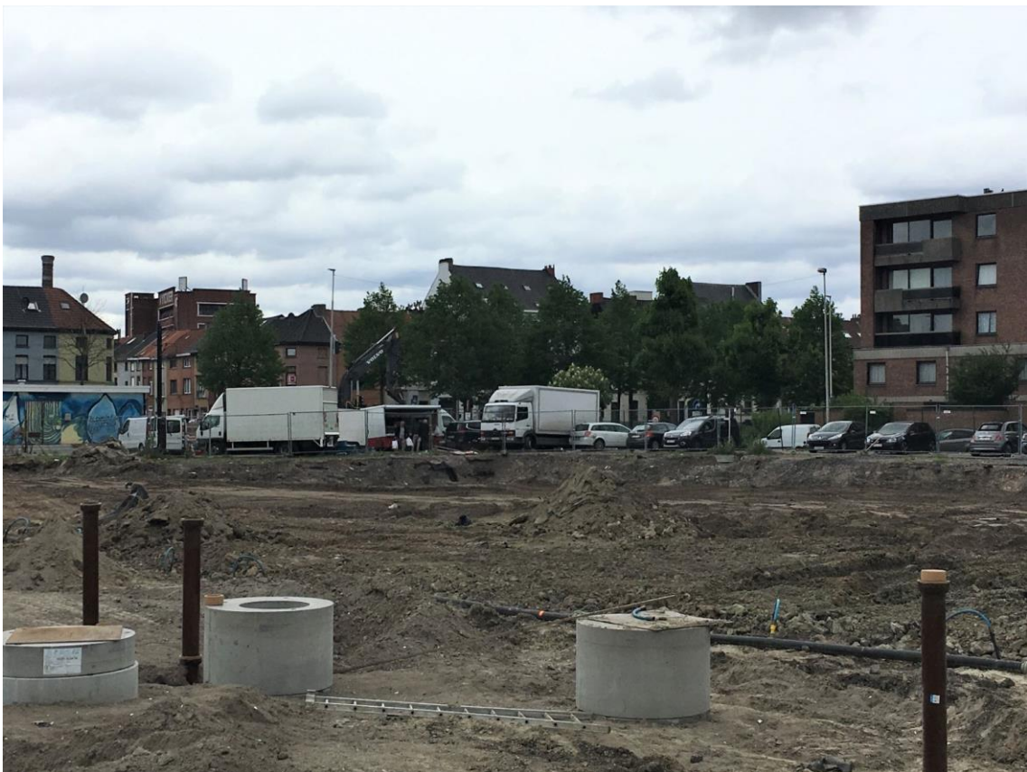
Figuur 7: Uitgravingen ter hoogte van het onderzoeksgebied
