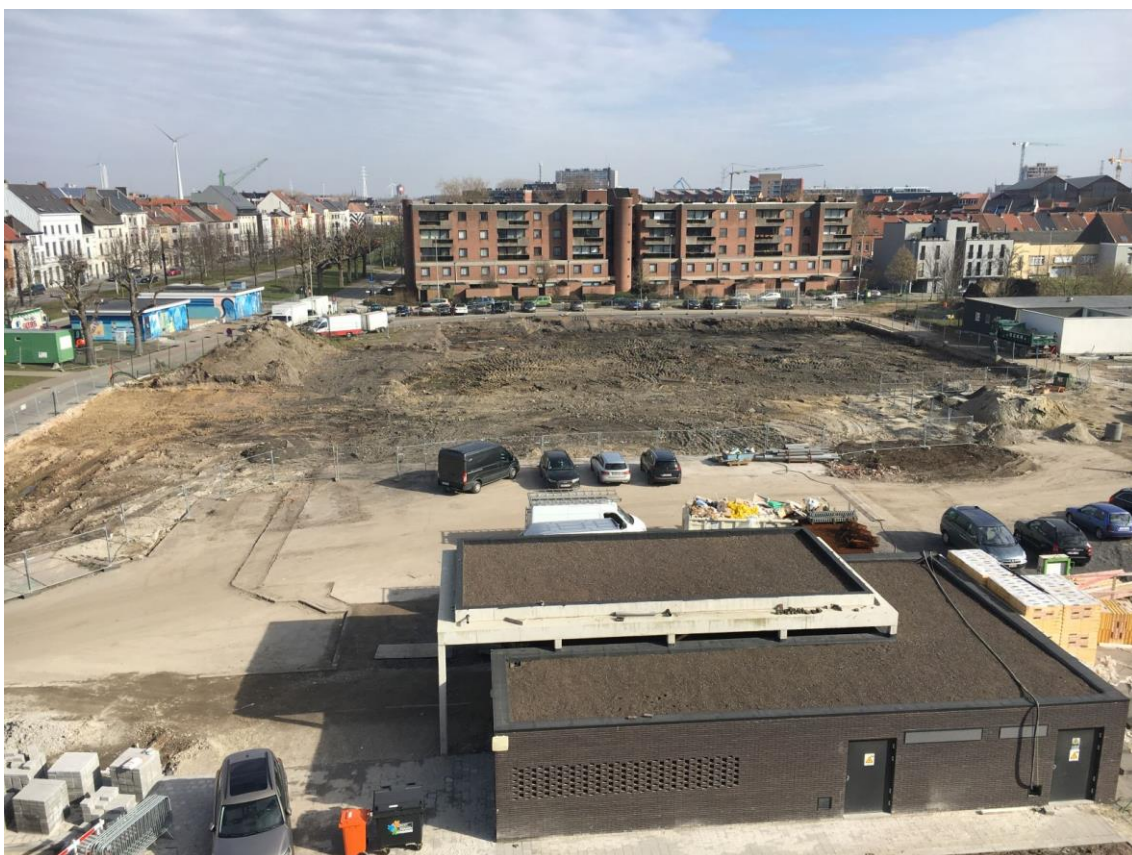
Figuur 5: Uitgravingen ter hoogte van het onderzoeksgebied
