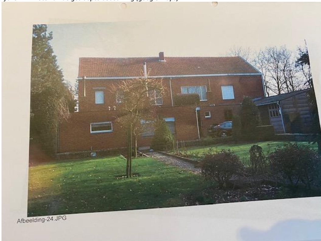
Afb. 9. Tuinzone van de gesloopte bebouwing.
