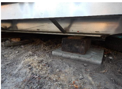
Fig. 7: Voorbeeld van fundering zoals aangemaakt onder één van de chalets op het aanpalende perceel
