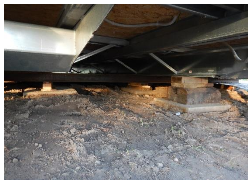
Fig. 7: Voorbeeld van fundering zoals aangemaakt onder één van de chalets op het aanpalende perceel
