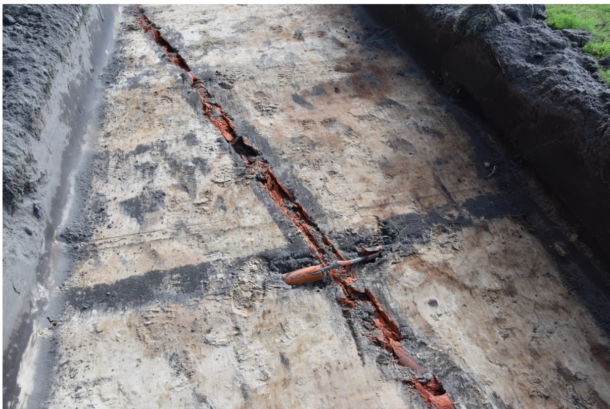
Fig. 2.15: Drainagebuis en nutsleiding in sleuf 4.
