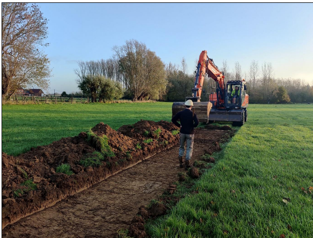
Figuur 37: Werkfoto van de aanleg van een proefsleuf langs de Hollebeekstraat (ABO nv 2020)
