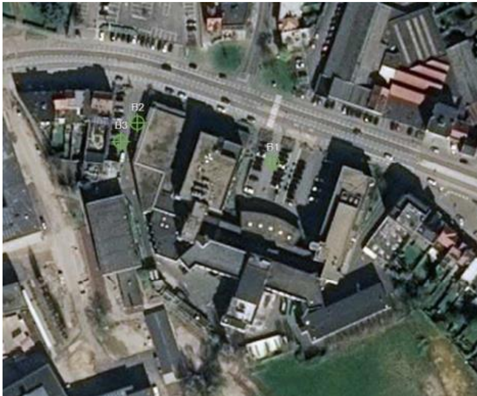
Figuur 3: Aanduiding van de uitgevoerde boringen om de diepte van de verharding na te gaan 7
