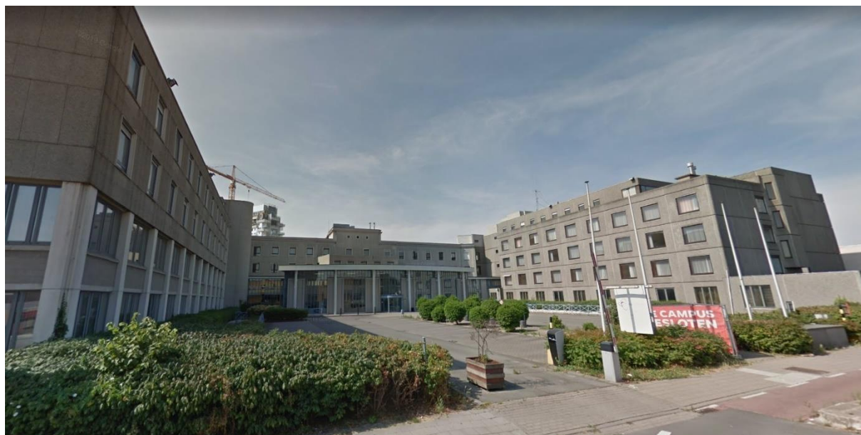
Figuur 1: Huidige situatie gezien vanuit het noorden 5
