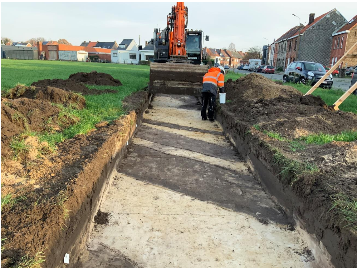
Figuur 5. Aanleg en registratie van de werkputten
