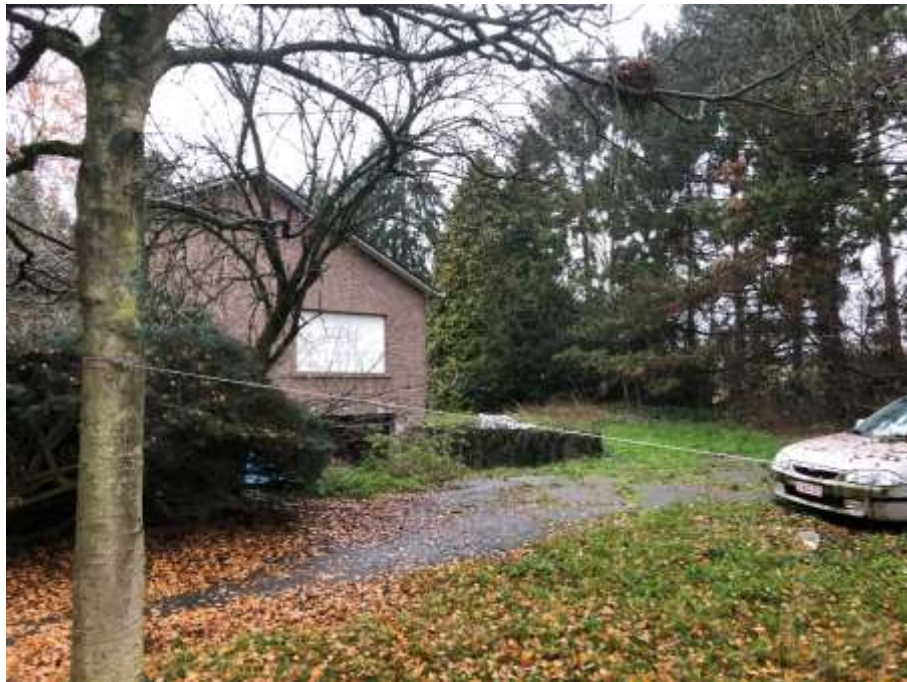
Fig. 1.8: Kelder en garage onder het woonhuis Nieuwstraat 19, achtergevel (© Initiatiefnemer).
