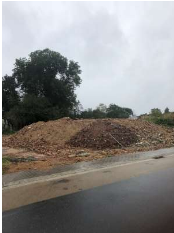
Fig. 1.10: voormalig woonhuis Nieuwstraat 27, nu gesloopt (© Initiatiefnemer).
