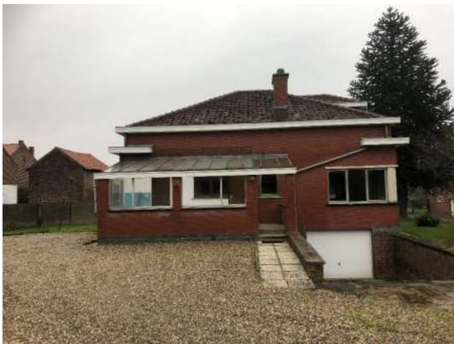
Fig. 1.6: Kelder en garage onder het woonhuis Nieuwstraat 25, achtergevel (© Initiatiefnemer).
