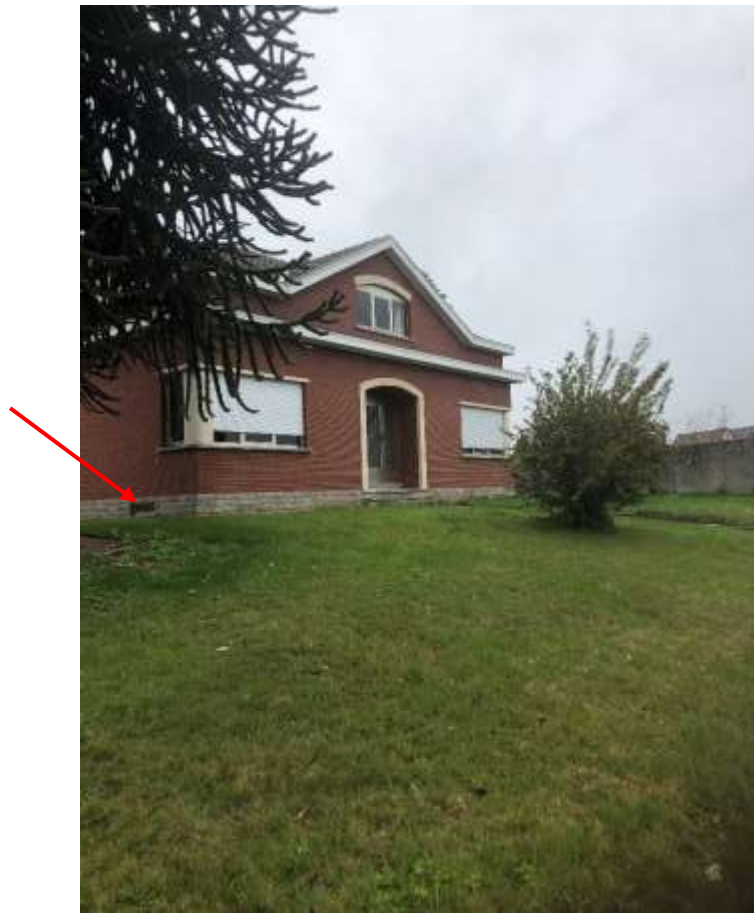
Fig. 1.7: woning Nieuwstraat 25, rooster van de kelder, rode pijl, zichtbaar vanaf de voorgevel van de woning ( © Initiatiefnemer).
