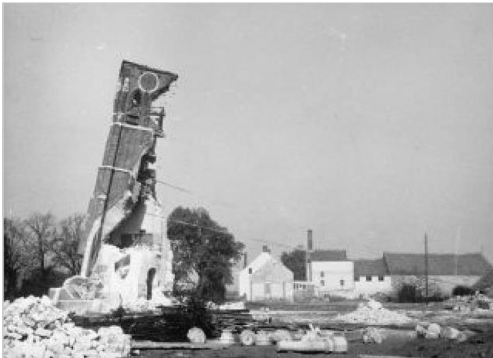
Figuur 41. Oorderen, sloop van de kerk (bron: ANONIEM, 1965a).
