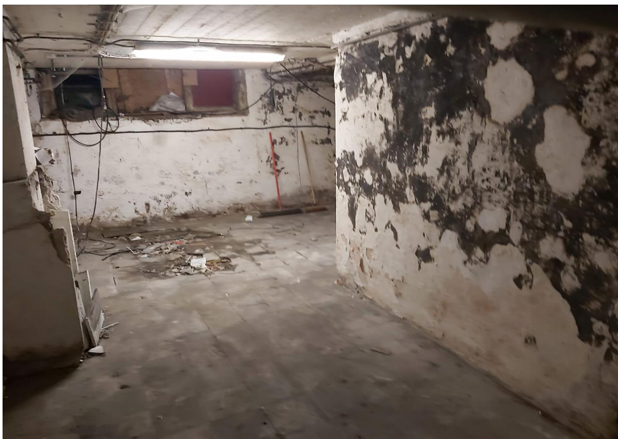
Figuur 7: De kelder bij de woningen gelegen te Bonenstraat 5 (ABO nv 2020)
