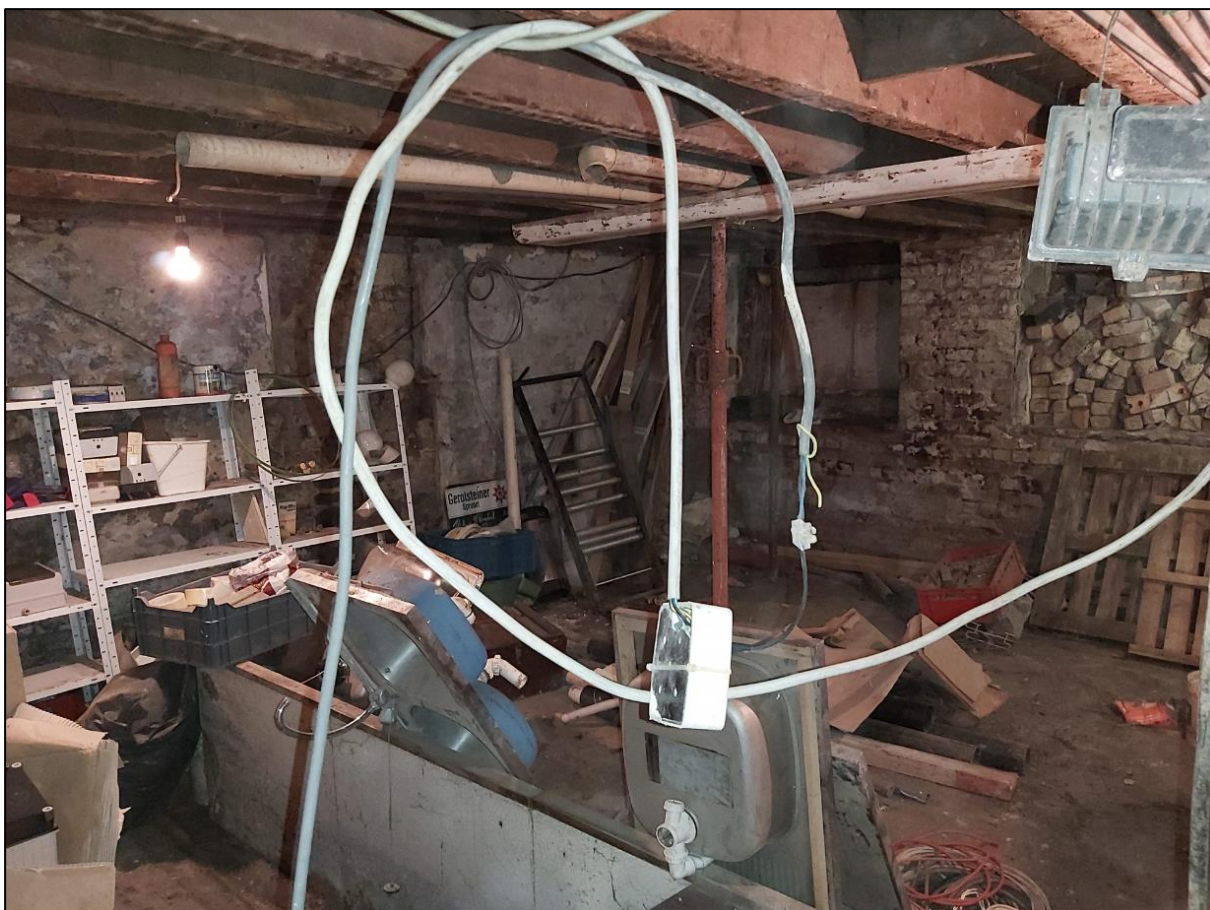
Figuur 8: De kelder bij de woning gelegen te Sint-Franciscusstraat 18 (ABO nv)
