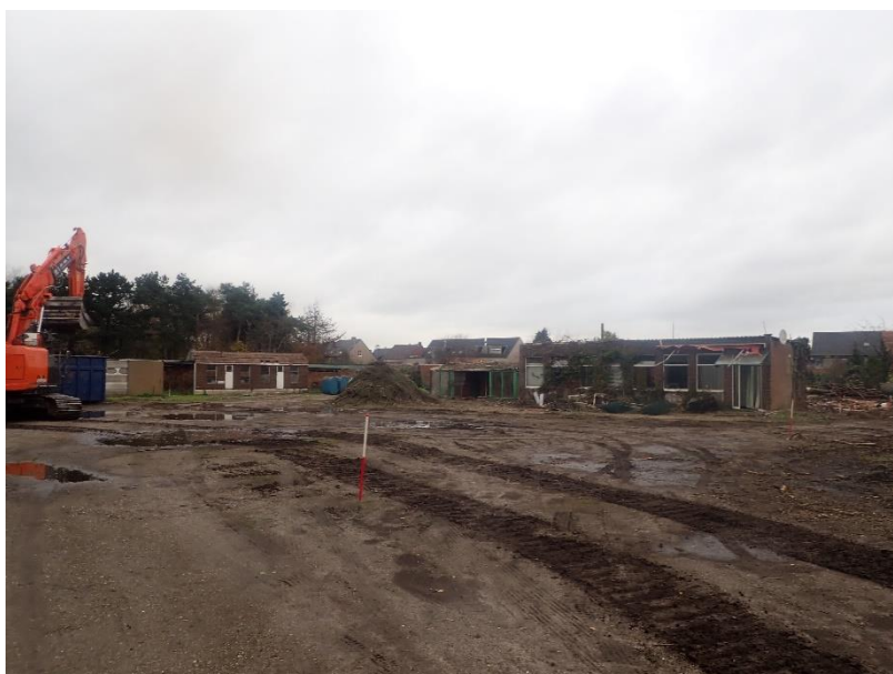
Figuur 19: Zicht op centrale gedeelte van het plangebied bekeken vanuit westelijke hoek (© J. Verrijckt Bvba).
