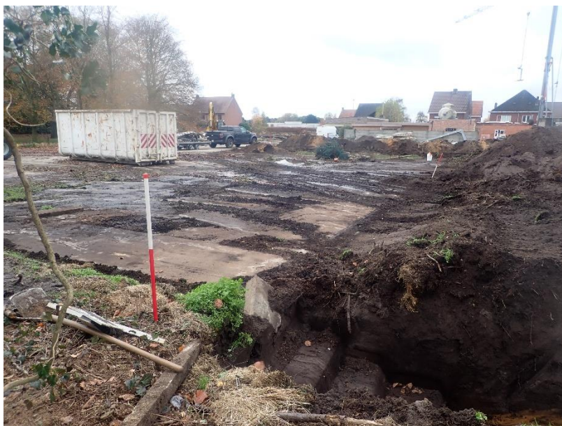
Figuur 22: Zicht op betonnen verharding bekeken vanuit noordoostelijke hoek (© J. Verrijckt Bvba).
