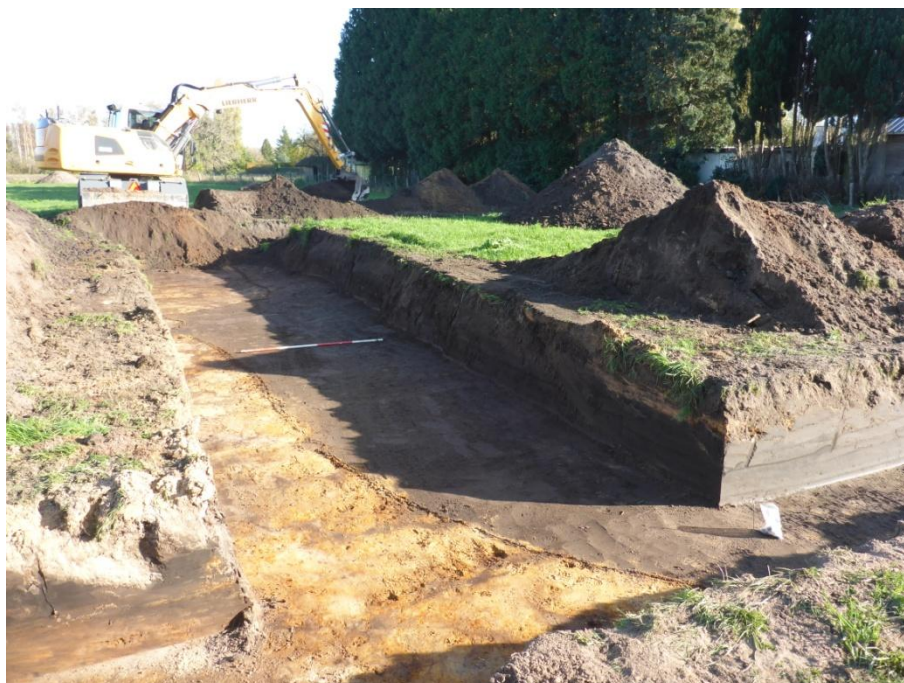
Afb. 37. S 23 na aanleg van de uitbreiding.
