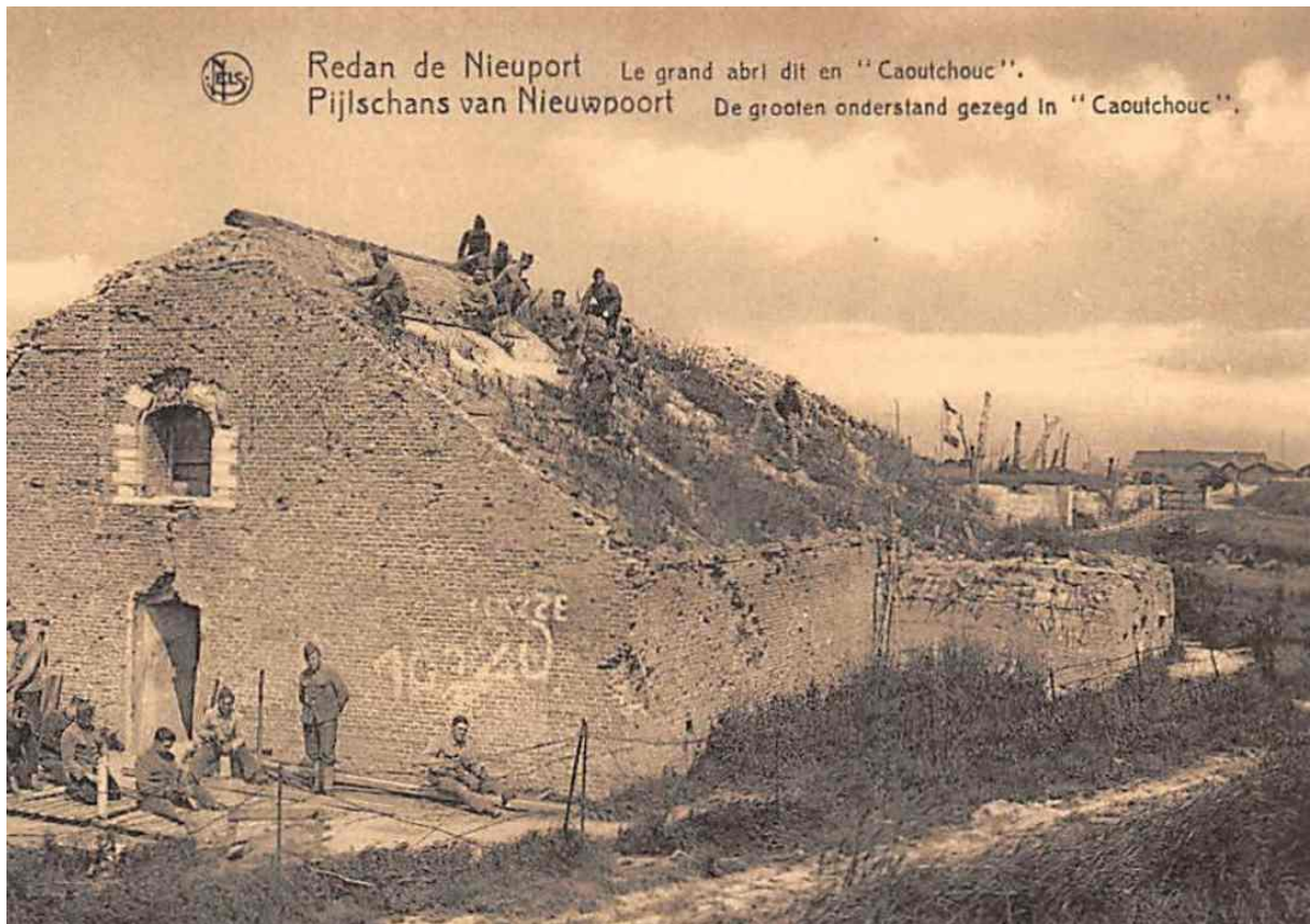
Figuur 28 "Rubber House" of "Caoutchouc" bunker / kruitmagazijn (bron: ebay.be)
