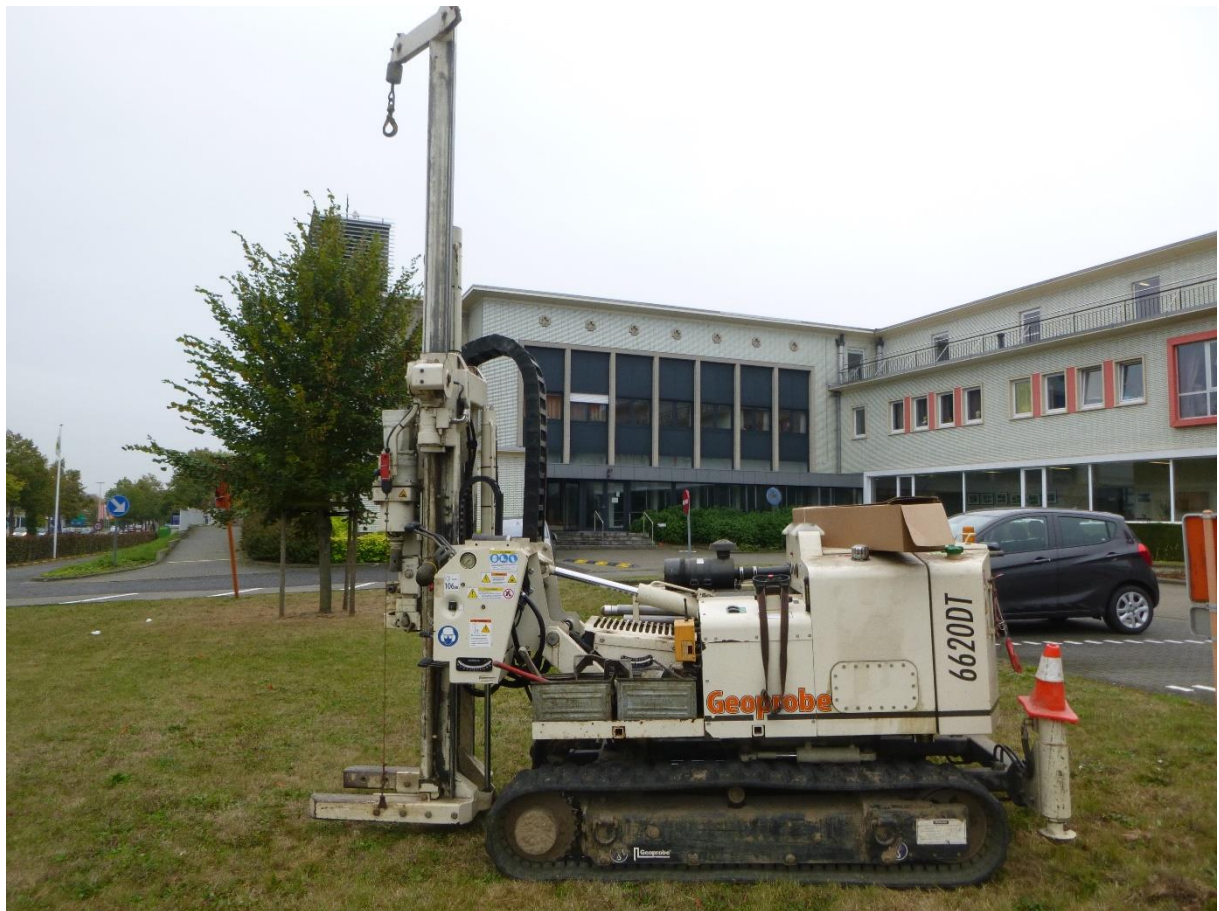
Figuur 33: Geoprobe boormachine die werkt gebruikt voor het uitvoeren van dit booronderzoek.
